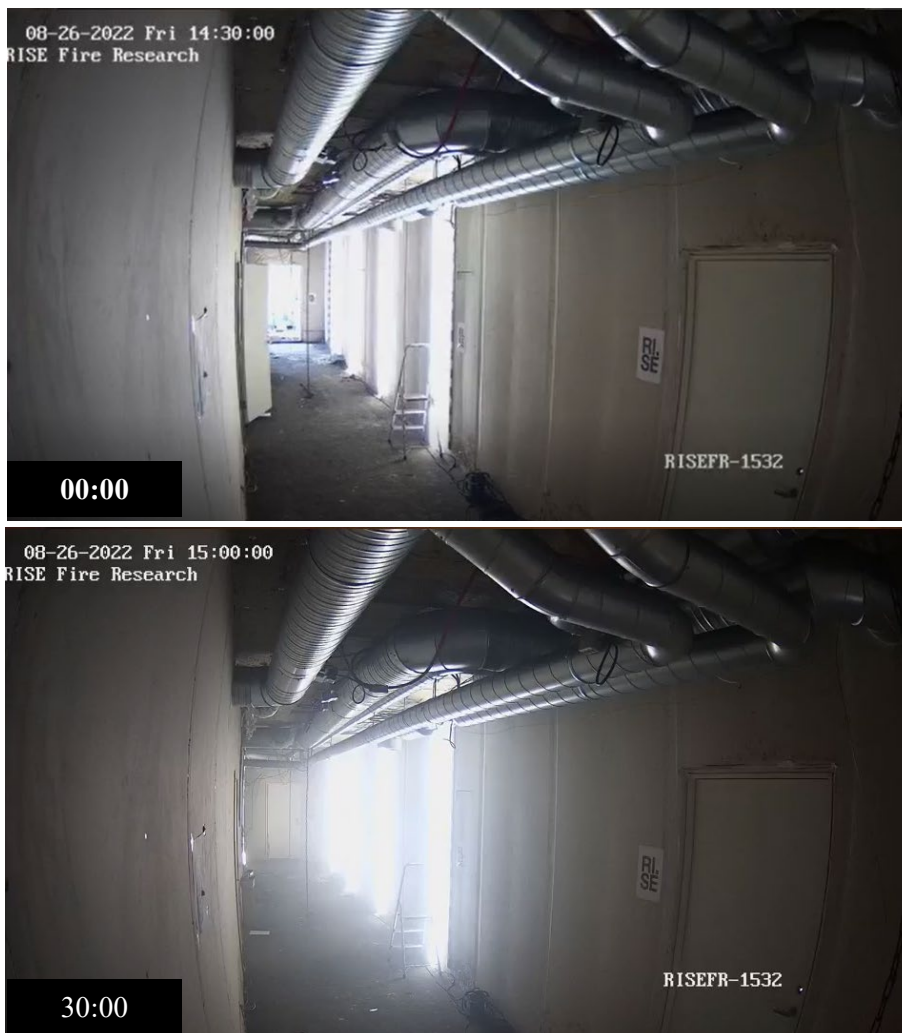
Figur 4-65: Bilde fra korridoren ved start av test 12 (øvre) og etter 30 minutter (nedre).
