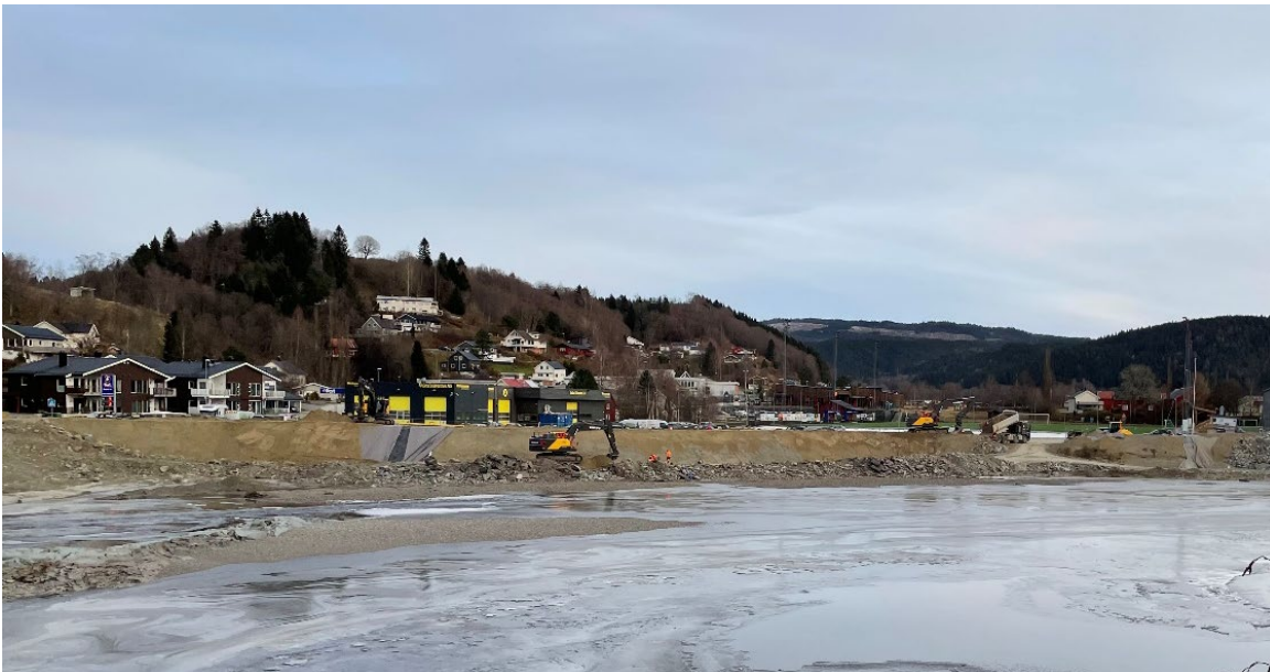
Figur 5. Flomsikringsarbeid ved Vuku november 2023.
