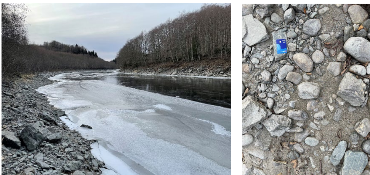
Figur 6. Forbygning og erosjonssikring på et parti i Helgåa nedenfor Rød. Til høyre et nærbilde av bunnen.
