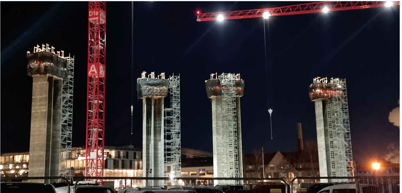
Betongteknologer kan beregne fasthetsutvikling i betong ganske nøyaktig, men ikke på flere steder samtidig. Derfor er modenhetssensorer til stor hjelp, de kan redusere standardisert herdetid med ca. 50 % for både standard- og lavkarbonbetong. Foto: Veidekke
