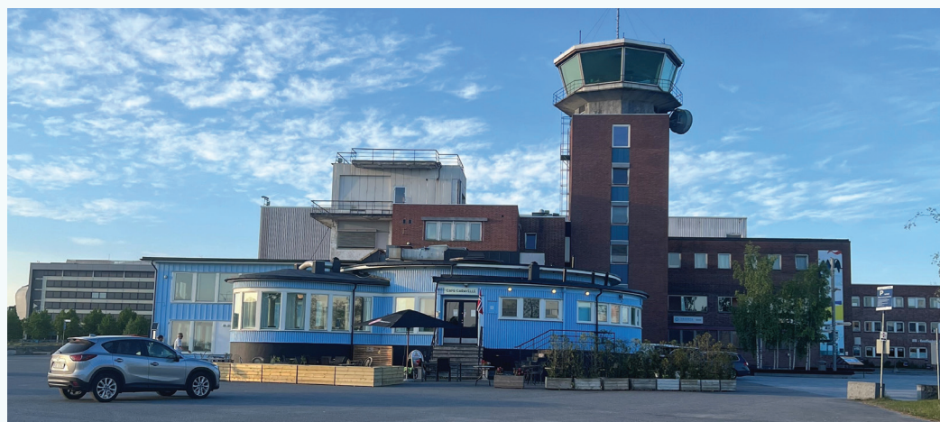
Bygg som skal beholdes i Flytårnet.
