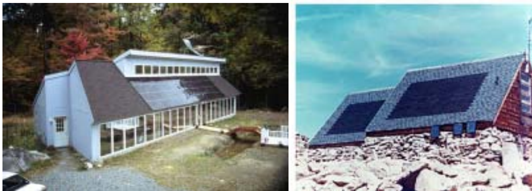
Figur 10.2 Solcellepaneler kan integreres i huset som del av tak- eller veggdekke.
