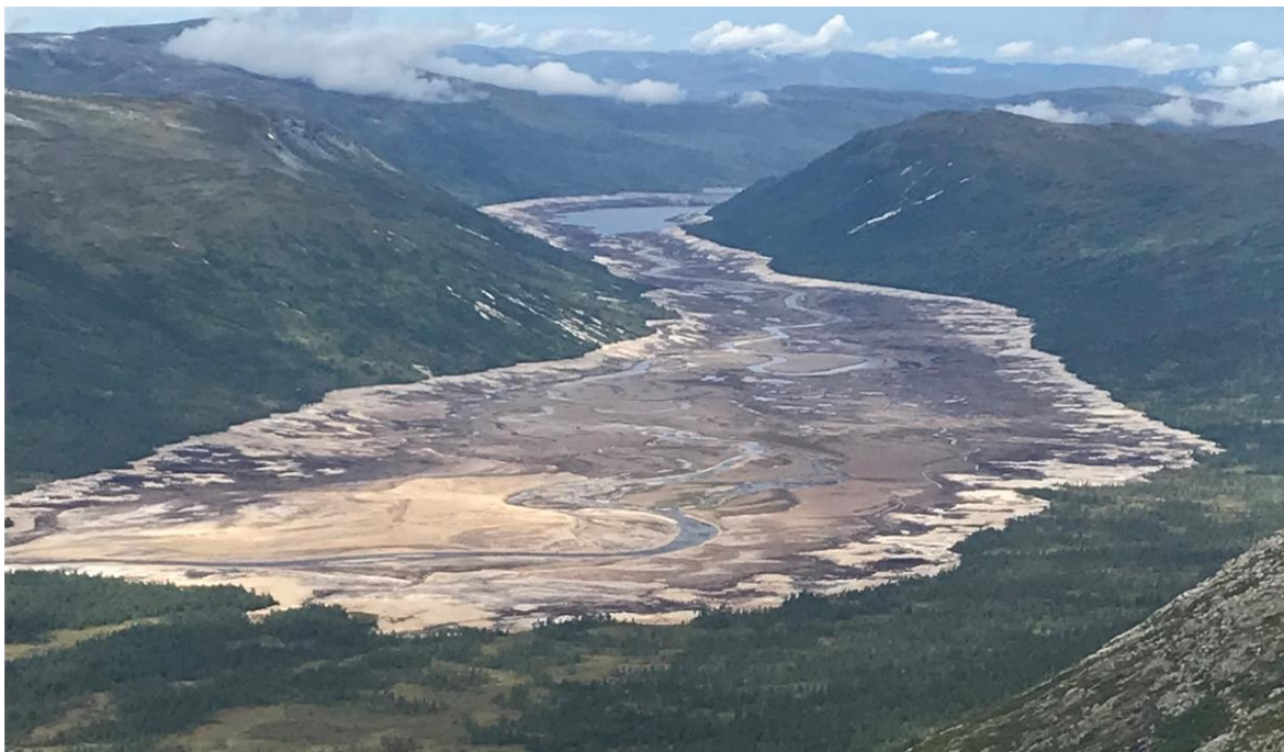
Figur 4. Gråsjø magasin nedtappet for vedlikehold av dammen sommeren 2021. Det er mulig å se hvor opprinnelig elv rant. (foto Atle Harby).
