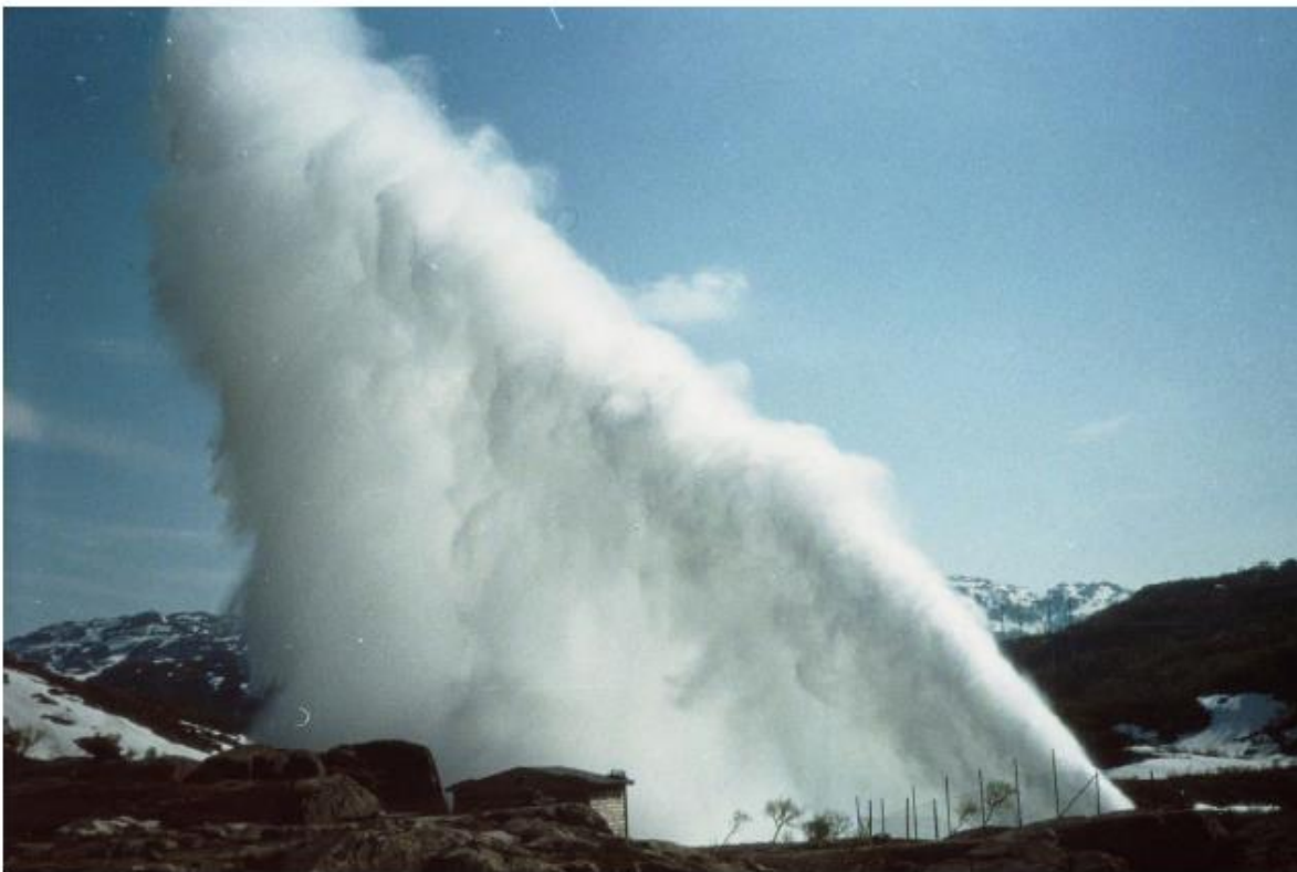
Figure 9: Air blowout in Holmaliåna secondary intake, Ulla Førre. Photo by Statkraft [22].
