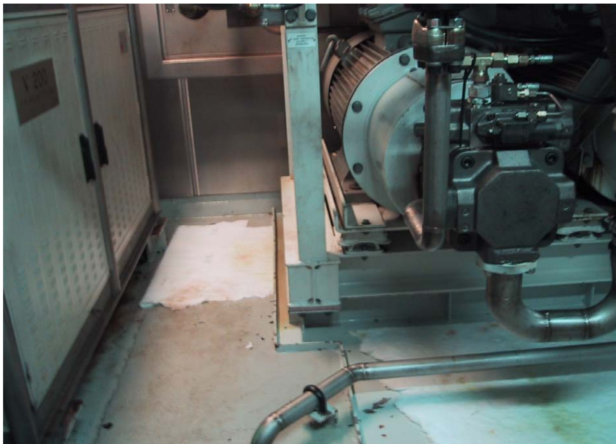
Figur 3: Hydraulikkrom D15 Heidrun . Oljesøl på gulvet absorberes i porøst papir og kastes i beholder for oljeholdig avfall.
