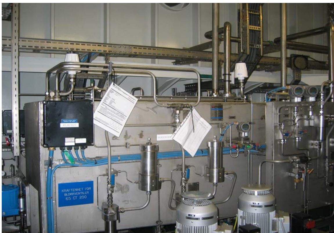
Figur1: Hydraulikkrom Åsgard B. Styrer ventiler i stag og noe på dekk.
