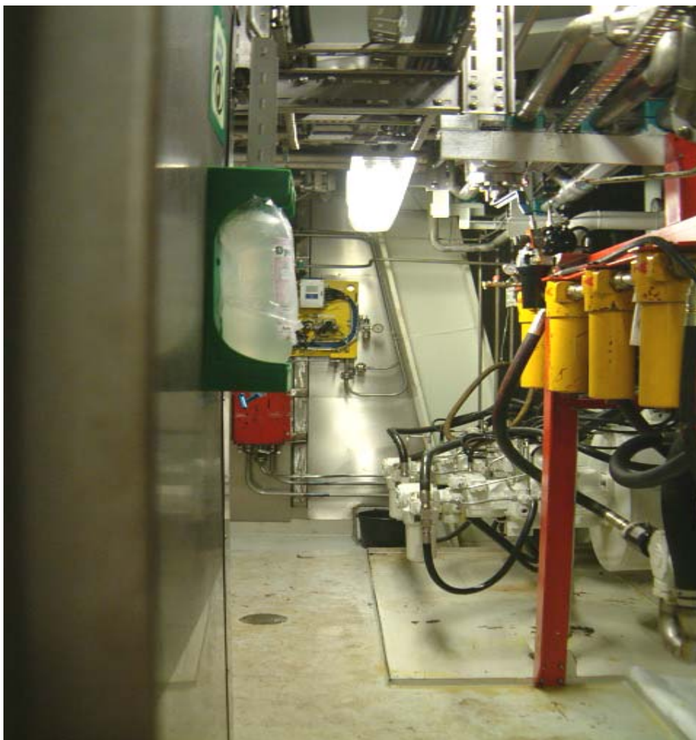
Figur 2: Hydraulikkrom i D20, 5 nivå, øvre UBIS Heidrun . Noen oljeflekker sees på gulvet foran tanken.
