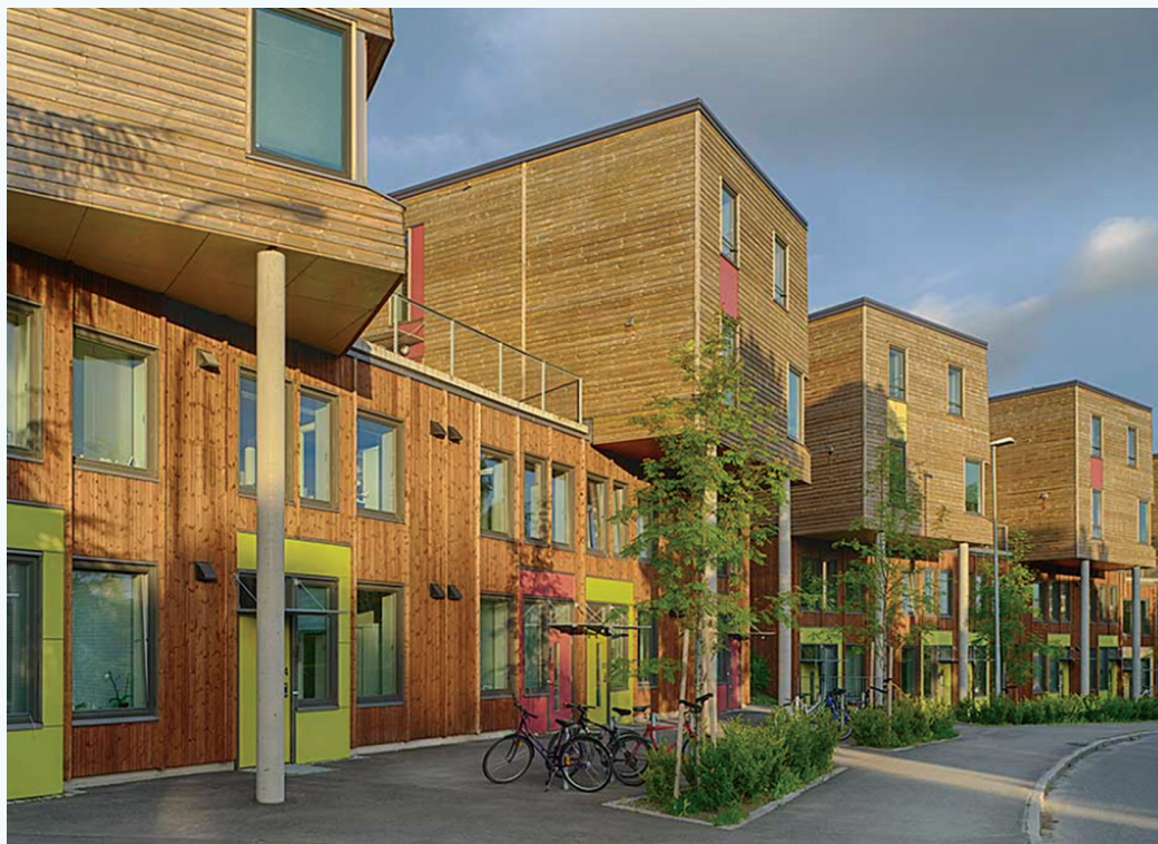
Berg Studentby – modulbygg av tre. Arkitekt: Skibnes Arkitekter AS.
