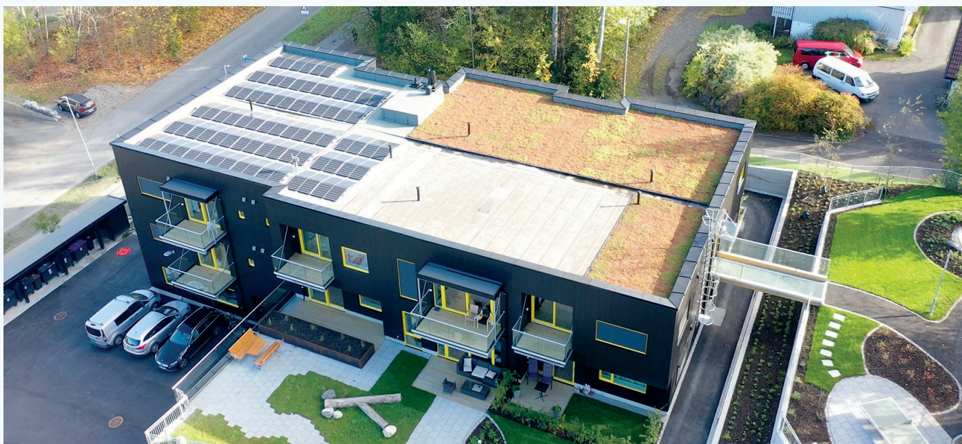
Dronefoto av Eiksveien 116, som viser blant annet solceller og vannfordrøyningsanlegg/grønt tak.
