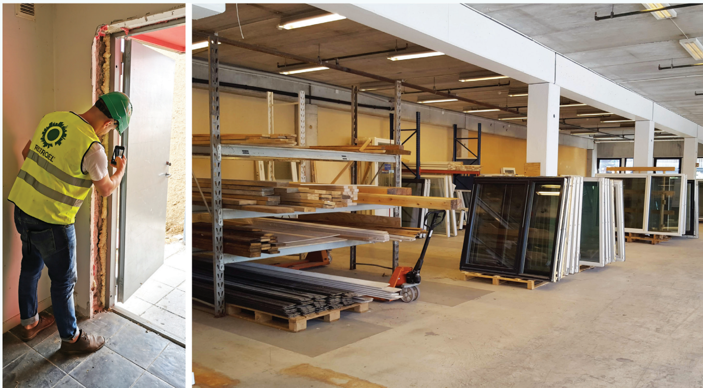
Her gjennomføres ombrukskartlegging av bygning for å identifisere bygningskomponenter som er egnet for ombruk. Gjennbrukbare komponenter mellomlagres for ombruk. Foto: Resirqel AS
