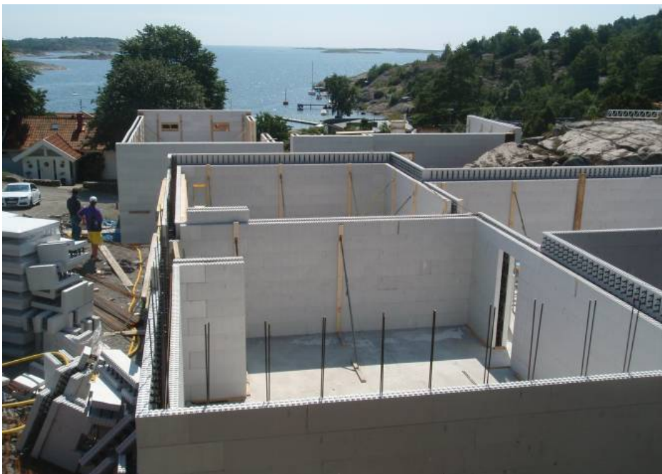
Figur 1 Thermomur byggesystem under oppføring. [Illustrasjon: Jackon AS]
