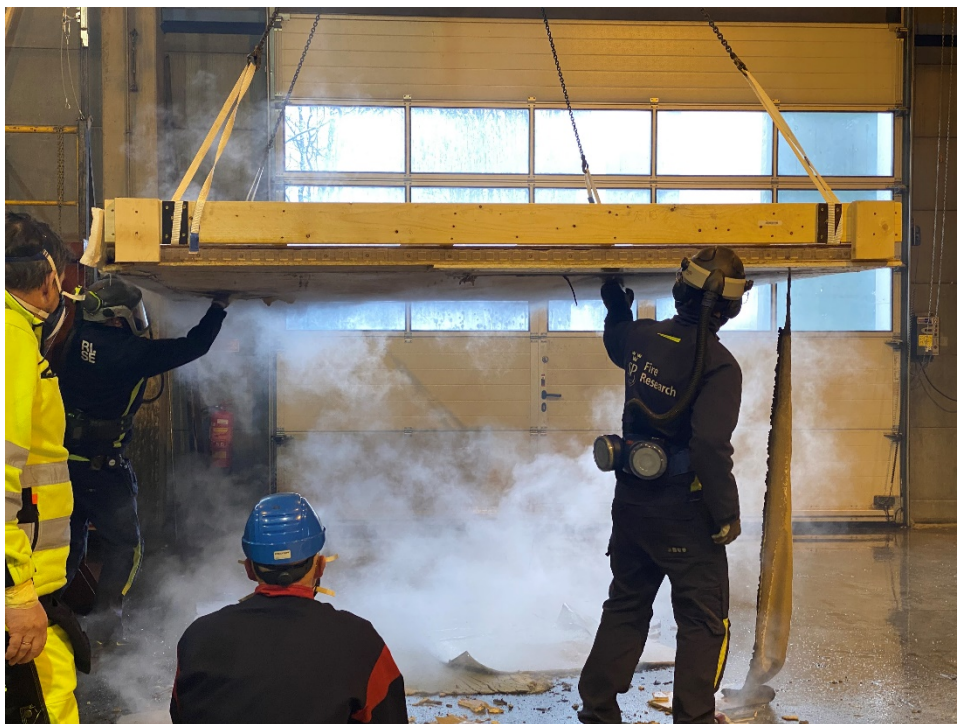
Figur 3 Brannteknisk prøving av kledningssystem iht. EN 14135:2004. [Illustrasjon: SINTEF]
