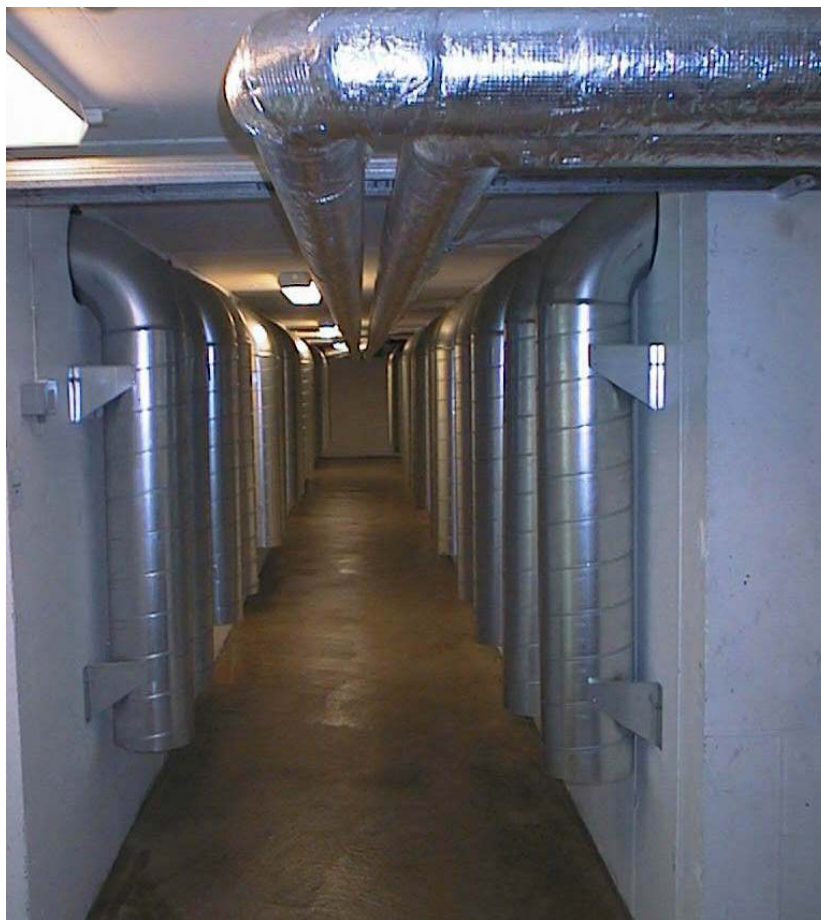
Figur 7. Kulvert som går på langs av kontorfløy. De vertikale kanalene går over i kanaler gravd ned i grunnen under gulv i første etasje. Disse fører luft til hvert kontor/modul.
