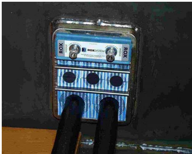
Figur B.7 Roxtec EMC gjennomføring vart nytta i avkoplingspunktet for kablane i ein del av målingane.
