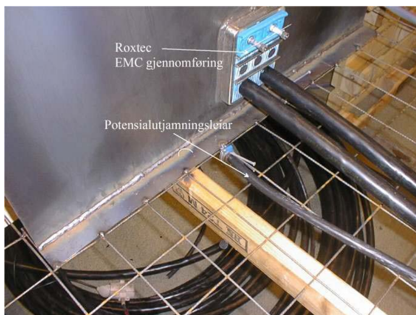
Figur B.22 Detaljar frå terminering av potensialutjammingsleiar mot gjennomføringsplate.
