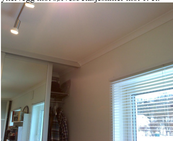
1. et.: kontor 1, yttervegg mot nordvest/skillevegg mot trapperom/etasjeskiller mot loft
