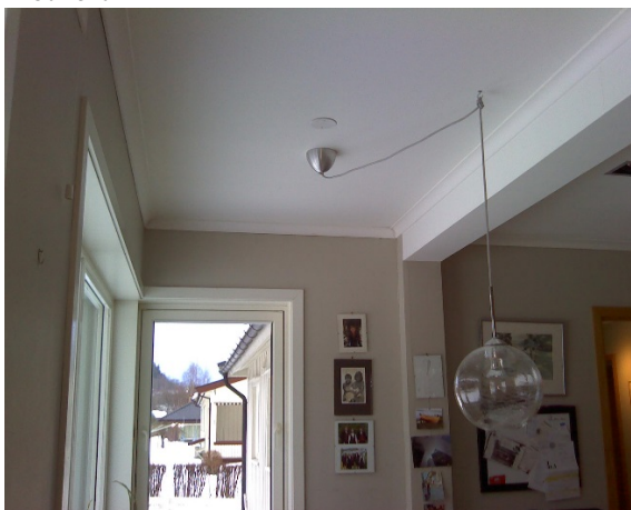
1. et.: kjøkken, tilbygg mot nordvest-nordøst/skillevegg mot trapperom/etasjeskiller mot loft
