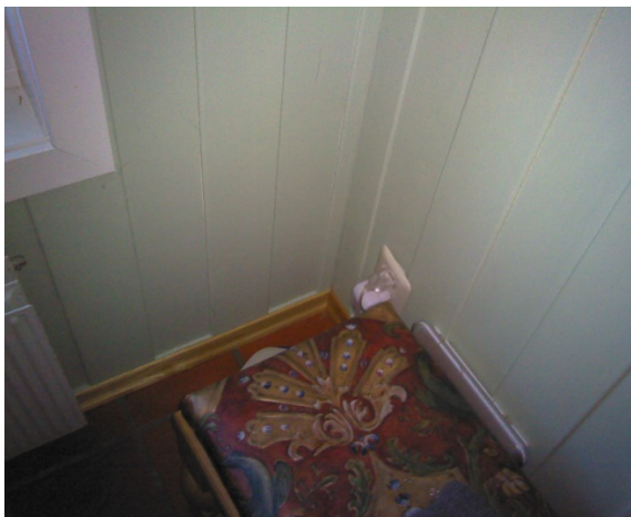
U-et.: hall, yttervegg mot sørøst/skillevegg mot vindfang
