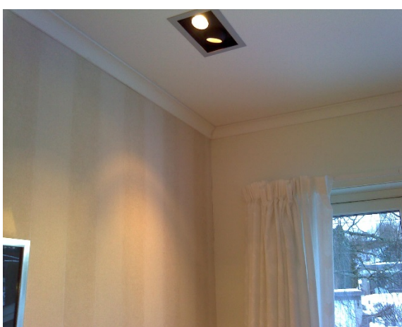
1. et.: stue, vinduer i yttervegg mot sørøst/yttervegg mot balkong/etasjeskiller mot loft
