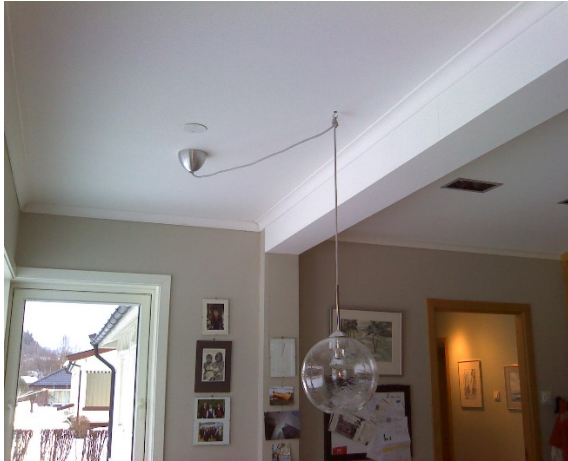
1. et.: kjøkken, tilbygg mot nordøst/skillevegg mot trapperom/etasjeskiller mot loft
