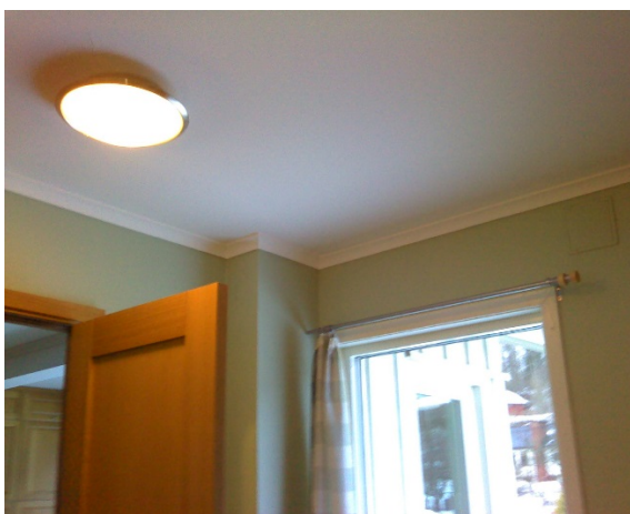
1. et.: trapperom, skillevegg mot kjøkken/yttervegg mot nordvest, etasjeskiller mot loft
