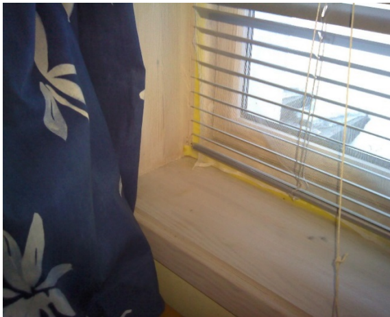
U-et.: soverom i tidligere garasje, vindu i yttervegg mot sørøst
