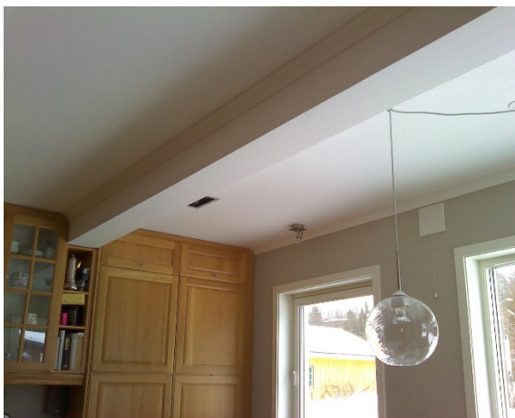
1. et.: kjøkken, tilbygg mot sørvest-nordvest/skillevegg mot stue/etasjeskiller mot loft
