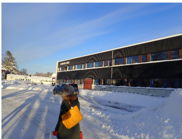
Sunnland skole. Foto SINTEF Byggforsk
