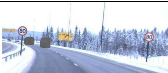
RV3 østover før Elverumkrysset. Fartsgrense skiltet på begge sider av kjørebane.
