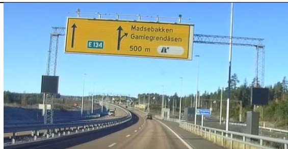
E134 vestover mot Kongsberg. Variabelt fartsgrenseskilt montert på begge sider av kjørebanelen. Størrelse SS. Ca. profil 950
