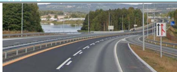
E6 nordover. Opplysning om Felt for fartsøkning bare montert på høyre side av kjørebanelen.
