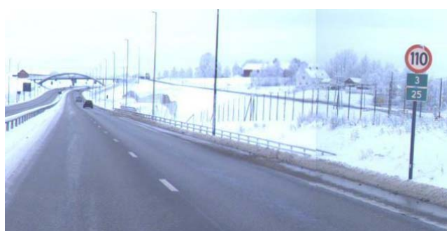
RV3 vestover. Skiltet fartsgrense etter kryss, kun på høyre side.
