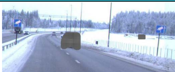
RV3 vestover. Skilt om Videokontroll/-overvåking satt opp på begge sider av kjørebane iht. Hb300-3 foran bomstasjon
