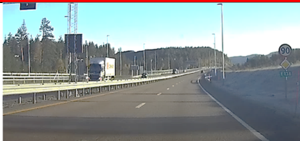
E134 østover fra Kongsberg. Fartsgrenseskilt på høyre side av kjørebanelen. Størrelse MS. Profil ca. 1550
