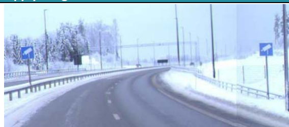
RV3 østover. Skilt om Videokontroll/-overvåking satt opp på begge sider av kjørebane iht. Hb300-3 foran bomstasjon.
