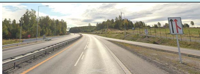
E6 sørover. Opplysning om Felt for fartsøkning bare montert på høyre side av kjørebanelen.
