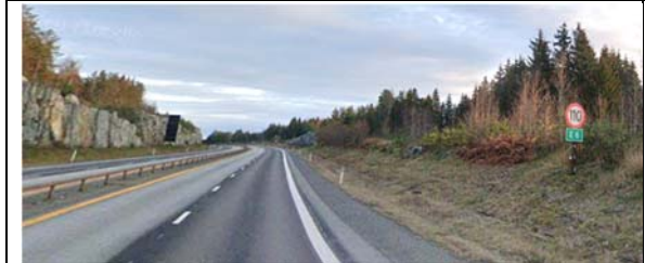
E6 nordover. 110 km/t. Skilting på høyre side av kjørebanelen. Størrelse stor. Merk avstanden fra skulderkant til skilt som er over anbefalt 4 meter.
