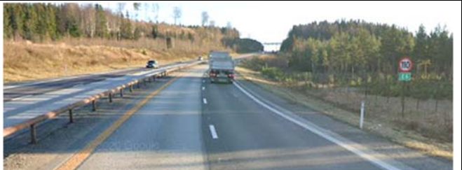
E6 sørover. 110 km/t. Skilting på høyre side.
