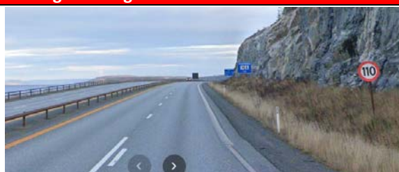
E6 nordover. Skilting på høyre side av kjørebanelen. Størrelse stor.
