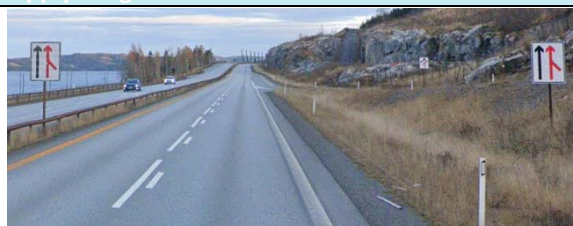
E6 nordover. Opplysning om Felt for fartsøkning på begge sider av kjørebanelen. Størrelse Stor
