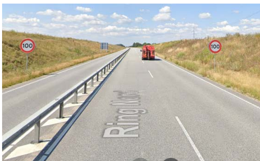
Figur 27: 2+1 veg med 100 km/t med stålrekkverk i midtdeler (Google maps/Streetview)
