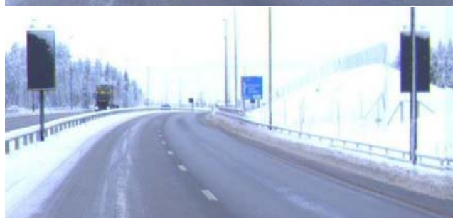
Variable skilt i tilknytning til vektstasjon. Plassert på begge sider av kjørebanelen.
