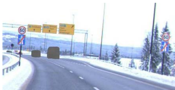
RV3 østover. Slutt på motorveg (kombinert med fartsgrense) skiltet på begge sider av kjørebanelen.
