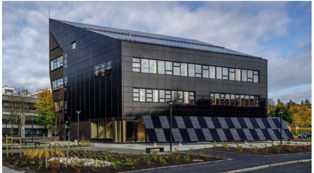
ZEB-laboratoriet på Gløshaugen i Trondheim har bygningsintegre solceller på alle flater med stor nok soltilgang. Resten av fasadane har trekledning eller kledning av svarte plater. Foto: m.c.hertzog / visualis-images
