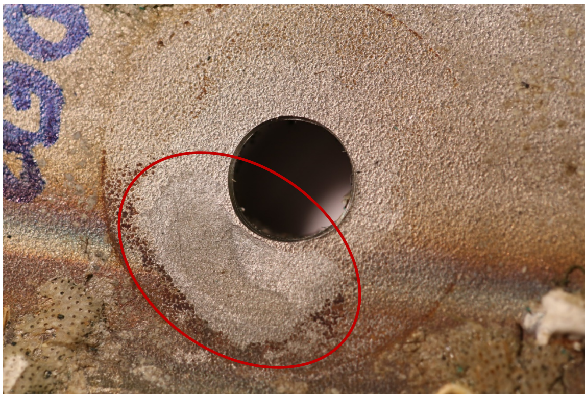
Figur 4. Spaltkorrosjon i varmepåvirket sone ved sveis på Prøve 3. Området var eksponert under vann. Angrepet er markert. Skala: Diameter på hullet i prøven er 6 mm.
