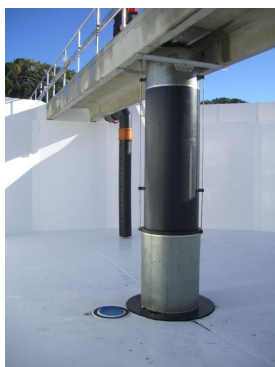
Partikkelfelle i sentrum av karet med sil for hovedavløp
