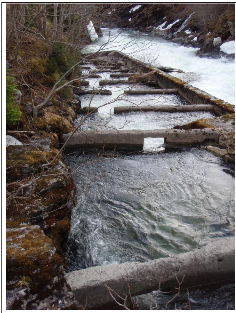
Figur 12. Fisketrappa i Berlifoss. I forkanten av bildet vises to terskler hvor fisken passerer mellom kulpene via dykkete åpninger (luker). Slike luker sikrer relativt konstant vannføring i trappa.
