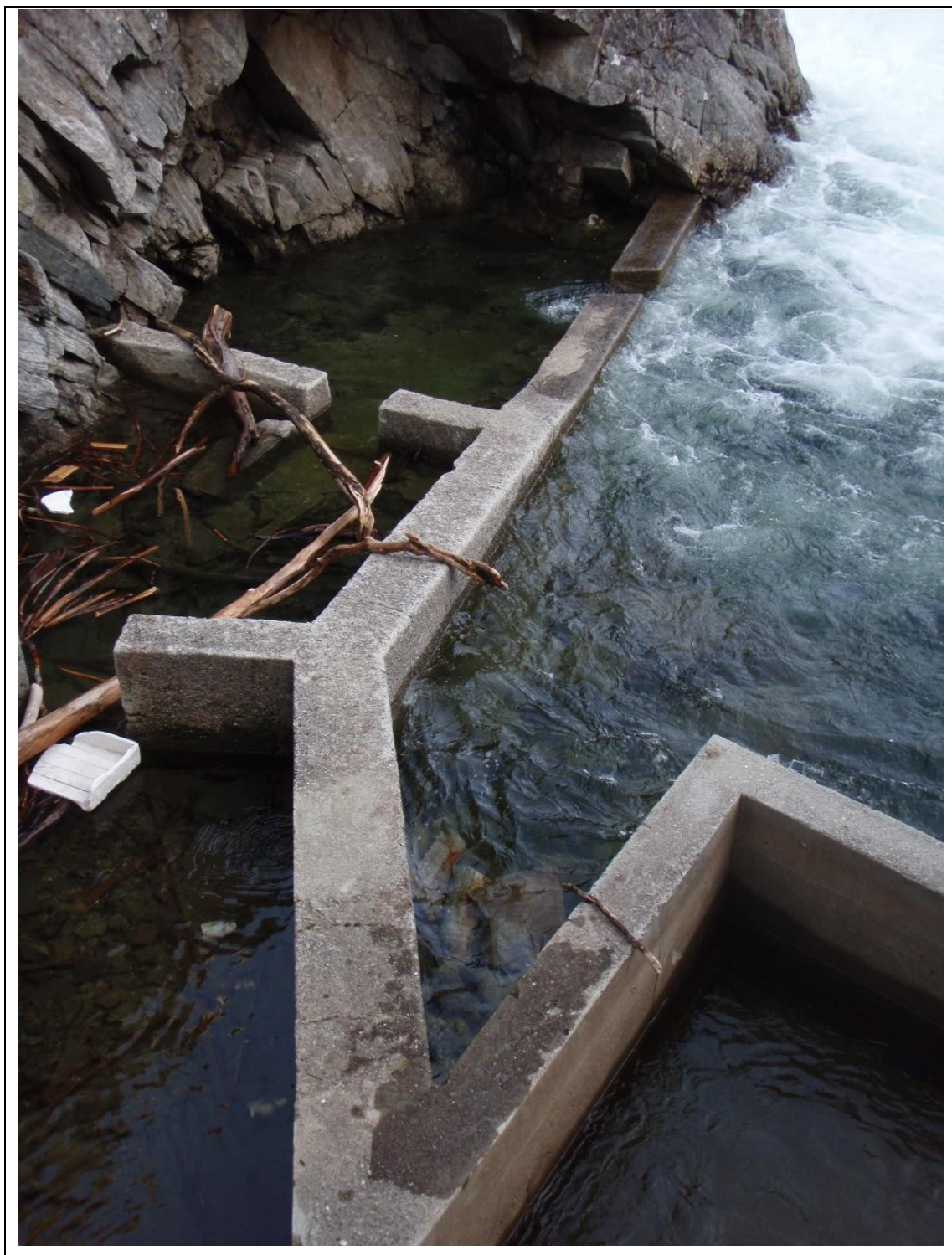
Figur 3. Den gamle, nedre delen av fisketrappa ved Hoelsfoss har ikke vannføring under vannføringen som vist.
