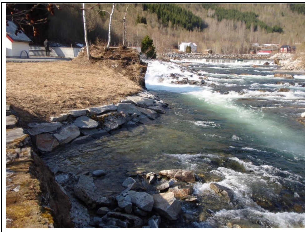
Figur 8. Utgangen av trappa i Hoelsfoss befinner seg rett under fotografen, mens overskuddsvannføring fra inntaksluka til kraftverket vises ca. midt i bildet. Inntaksdammen skimtes på tvers, øverst i bildet.
