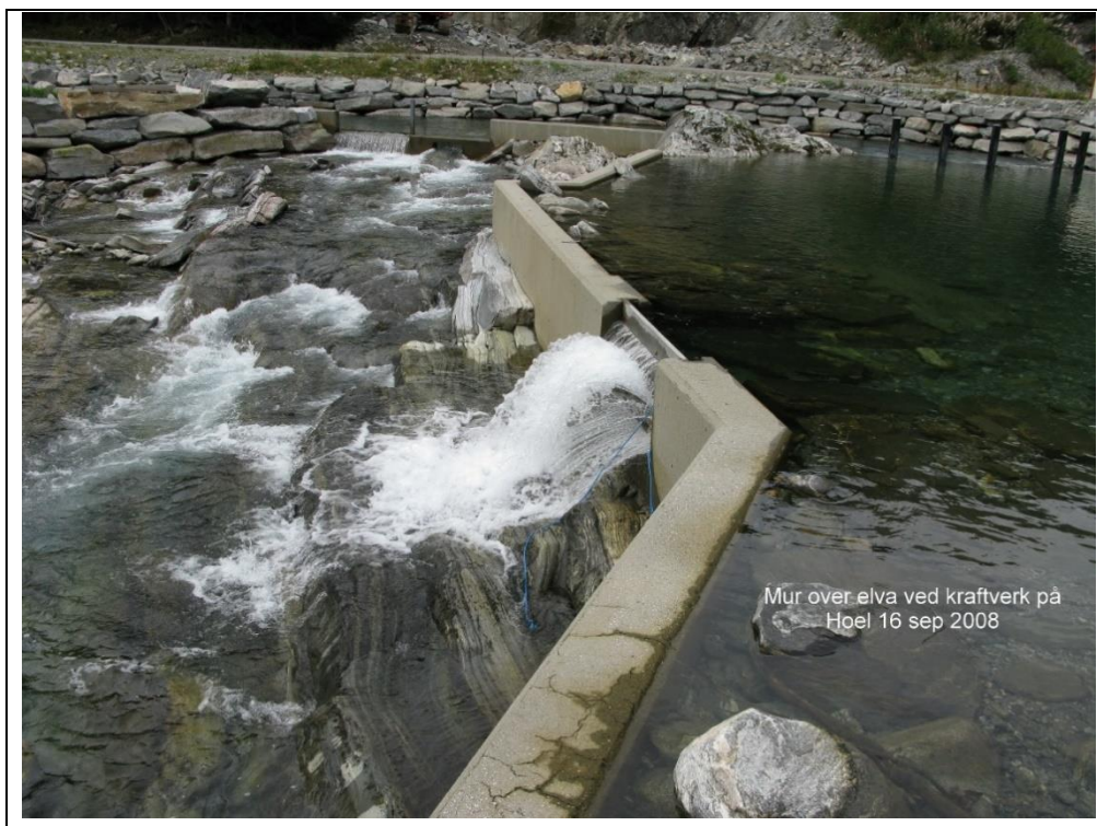
Figur 10. Inntaksdammen til Hoelsfoss kraftverk. Legg spesielt merke til at oppvandrende fisk mangler områder med tilstrekkelig dybde til å ta sats for å komme over (Foto: Stein Kristian Valdøl).
