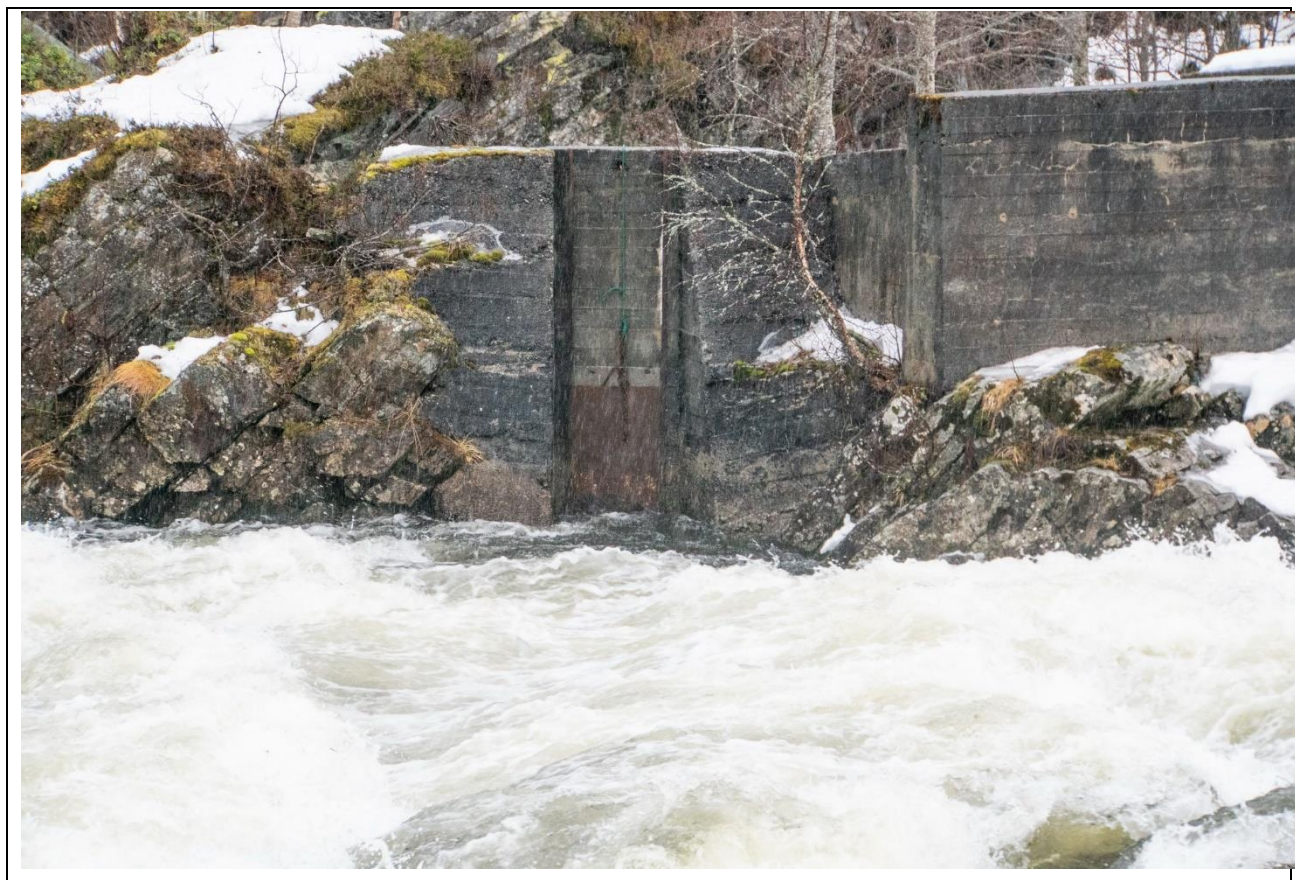
Figur 7. Vanninntaket til fisketrappa (utgangen for fisken) i Hoelsfoss. Området er grunt og eksponert, og inntaksområdet mangler god dybde for at fisken kan hvile og orientere seg når den kommer ut i elva. (Foto Aksel Døving).
