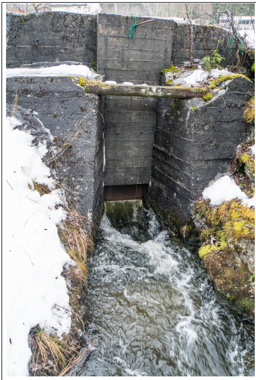
Figur 6. Luka fra fisketrappa og inn mot elva. Trappa er både trang og grunn. (Foto; Aksel Døving.)
