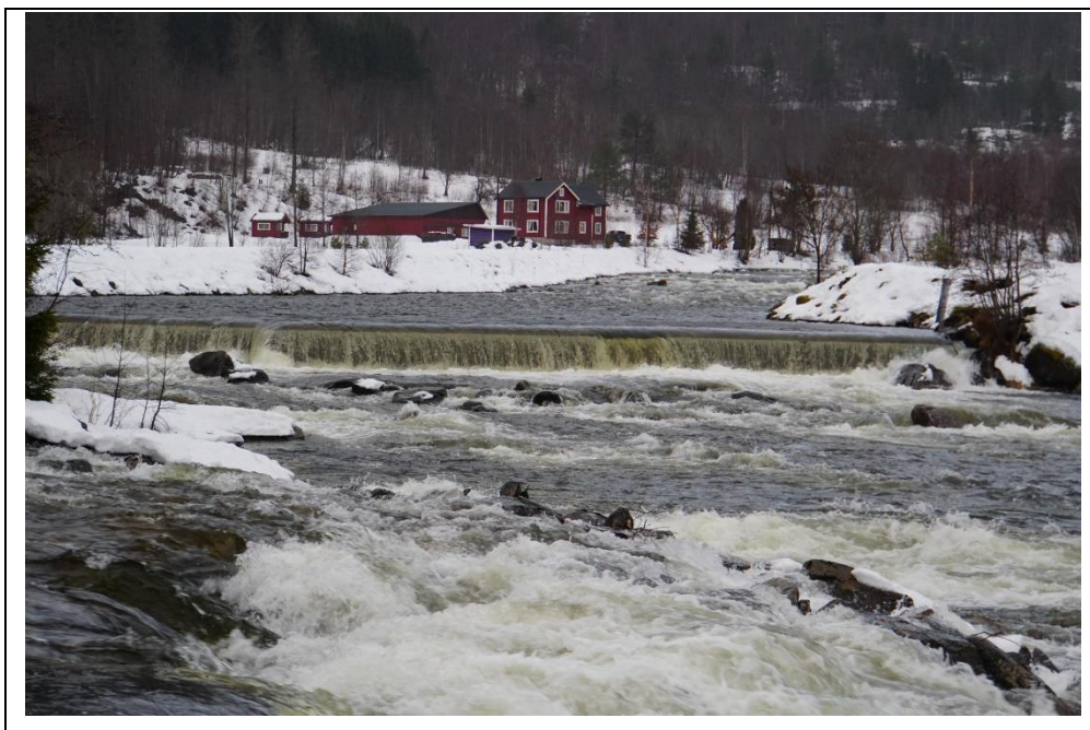
Figur 11. Inntaksdammen til Hoelsfoss kraftverk på høyere vannføring (29. desember 2019).
