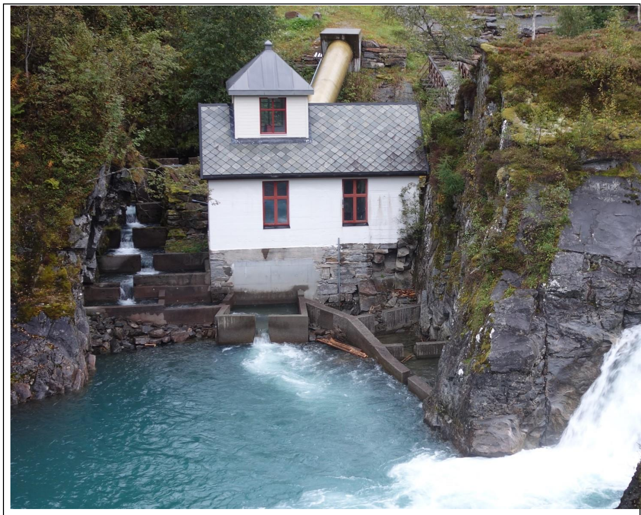
Figur 4. Utløpet av Hoelsfoss kraftverk. Den nye inngangen til fisketrappa er plassert sammen med utløpet fra kraftverket, mens den gamle fiskeinngangen inn mot fossefoten har en åpning fra kulpen med den nye inngangen. Det er ikke mulig å alternere mellom åpningene ved hjelp av luker.
