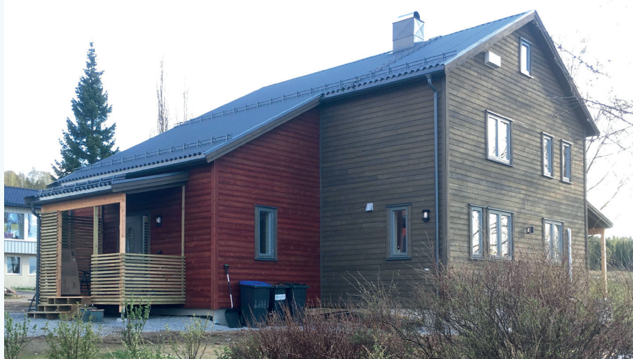
FØR OG ETTER. Eneboligen fra 1958 er energioppgradert til Enova nivå 1 (passivhus).
