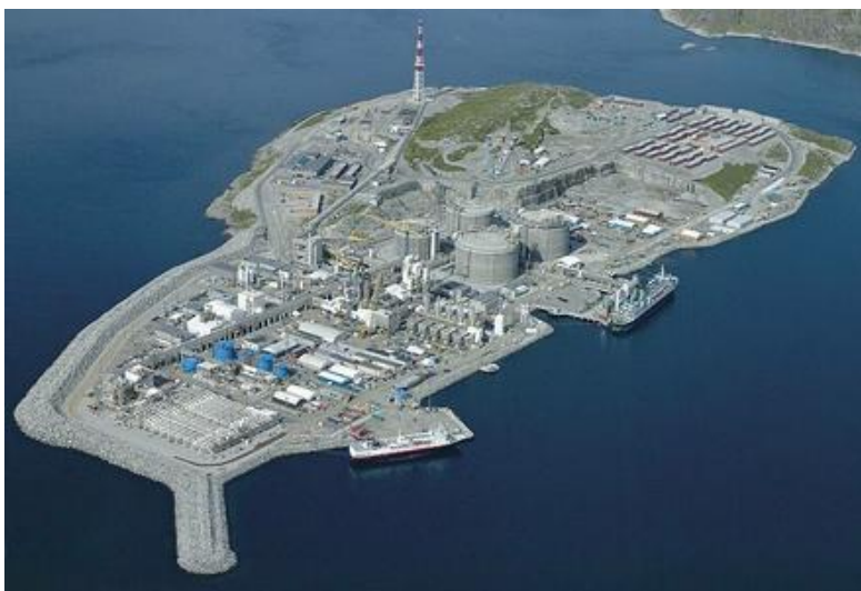
Figur 33 Melkøya-anlegget for mottak og prosessering av naturgass fra Snøhvitfeltet i Barentshavet. Bilde: Norsk petroleum.
