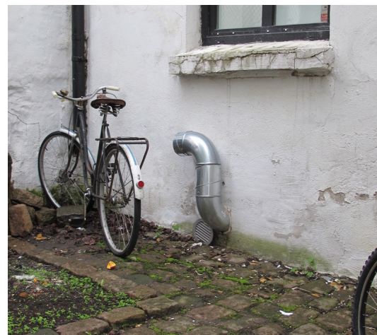
Foto, høyre: SINTEF Byggforsk
