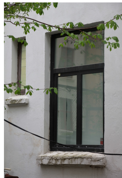
Foto, høyre: SINTEF Byggforsk
