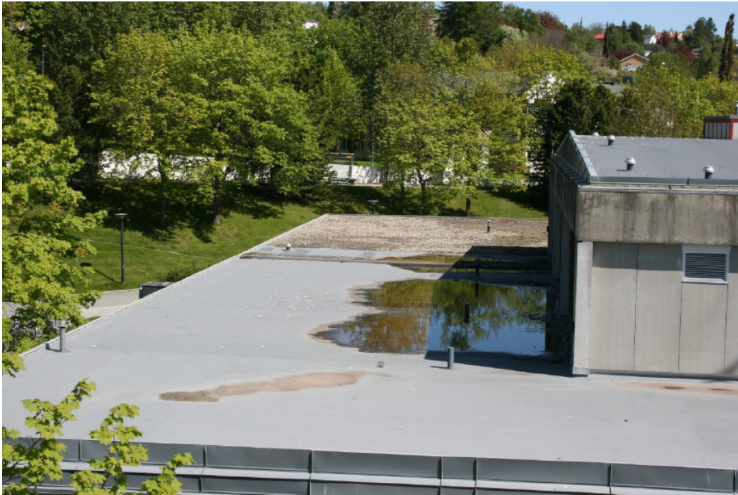
Figur 11: Flatt tak på Høyskoleringen 7B. Foto: Petter Martin Skjeldrum (2016)
