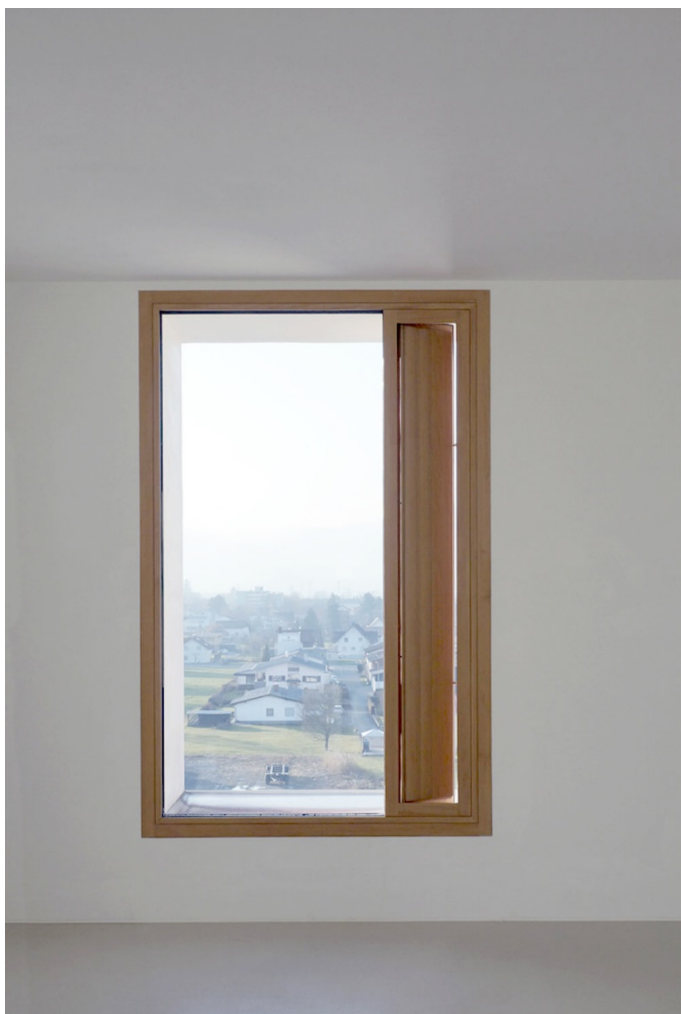
Figur 4 Vindu med åpen lufteluke i en normaletasje [2] (Foto: Jacob Schoof)
