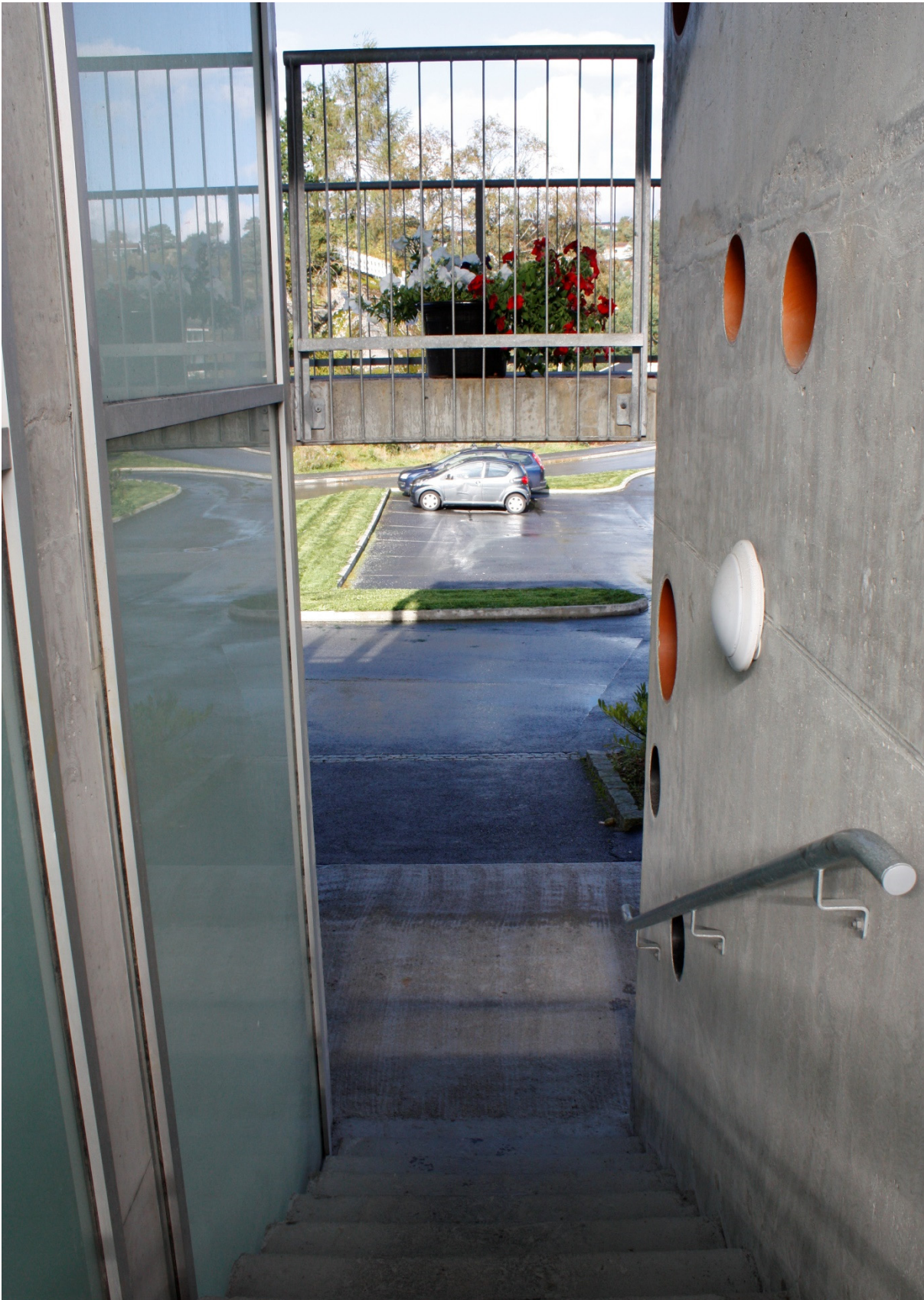
Trappehus med heis. Tertnes, Bergen. (Arkitekt: Cubus arkitekter).
