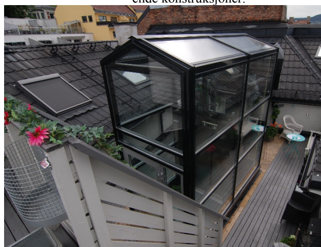
Det er etablert et forrom til heisen på plan 5, som ivaretar heistekniske krav til temperatur og beskyttelse mot regn og snø. Glass i gulvet gir dagslys i gårdsrommet under. (Foto Bråthens mekaniske).
