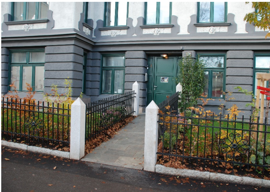
Trinnfri atkomst er etablert ved inngang A. Denne inngangen fremstår som hovedinngangen etter oppgraderingen.
