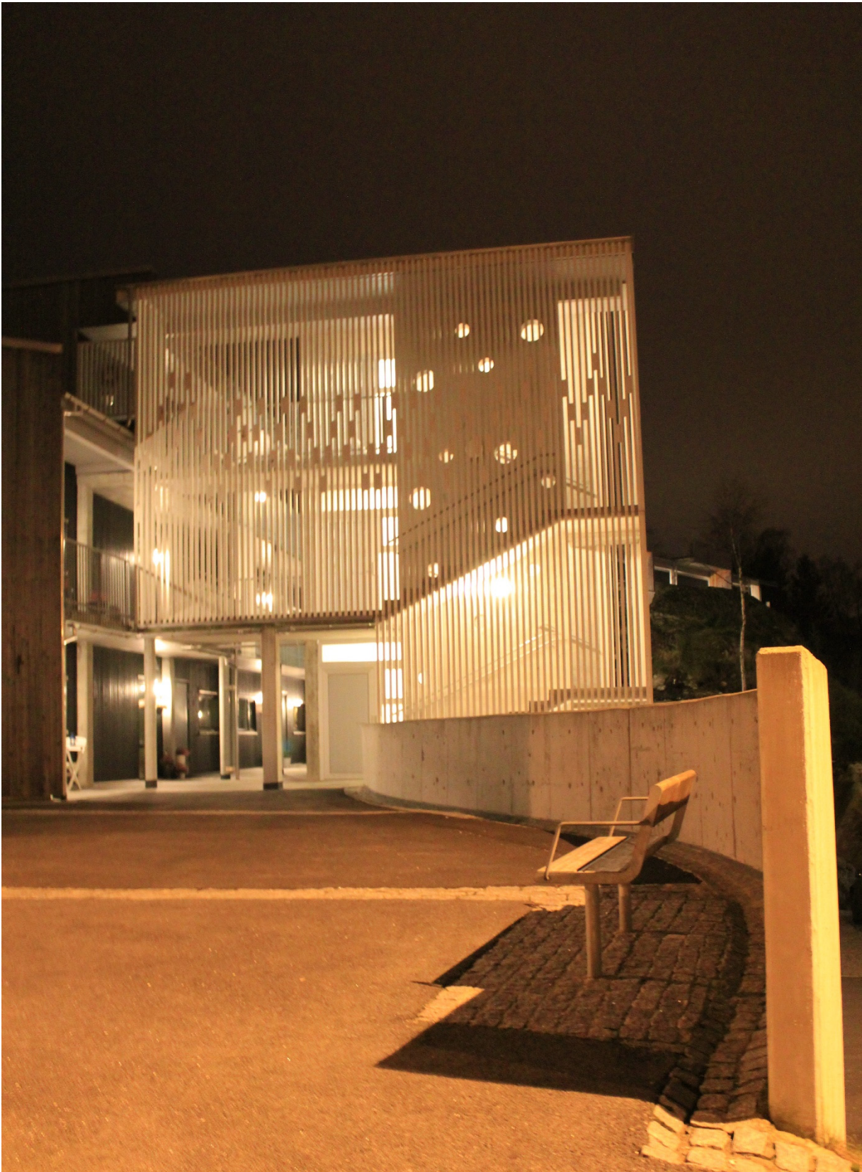
Trappehus med heis. Tertnes, Bergen. (Arkitekt: Cubus arkitekter). Boligprosjektet er nytt, men tilsvarende konsept kan brukes ved etterinstallering av heis. Heisen betjener parkeringskjelleren og 3 etasjer med boliger.
