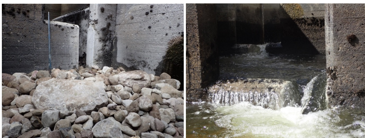
Figur 15 Bilder fra ombygging av kulpetrappen på Høyegga/Glomma til en spaltetrapp i rammen av SafePass-prosjektet (CEDREN, Foto: Ulrich Pulg).
