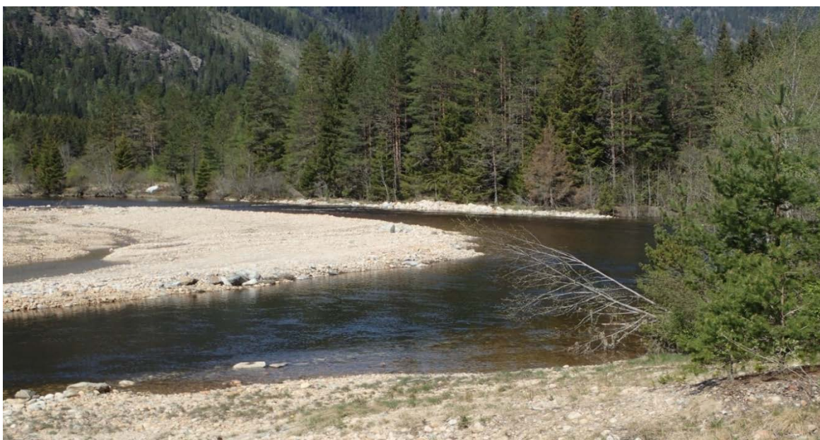
Figur 11 Omløp kan ha større omfang, slik som f.eks. «Blekeløpet» i Otra. Det er 460 m langt, utformet som naturtypisk elveløp av kulp-stryk-type, har dynamisk substrat i erosjonssikre rammer, og 7- 24 m bredde. Q_{\text{dimensjonerende}} 3-15 m 3 /s, gradient 0,002-0,008.
