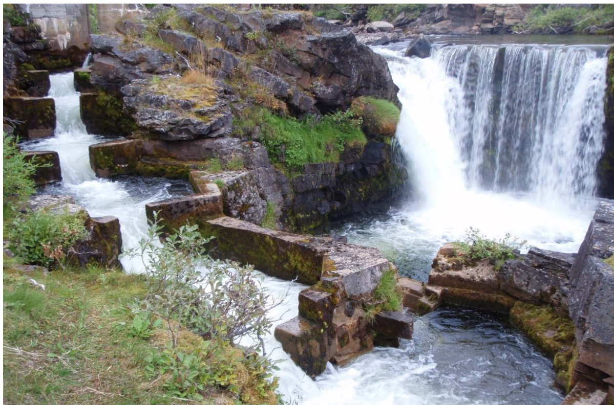
Figur 17 Klassisk kulpetrapp for laks i Bergebyelva, Finnmark. (Foto: Hans-Petter Fjeldstad)
