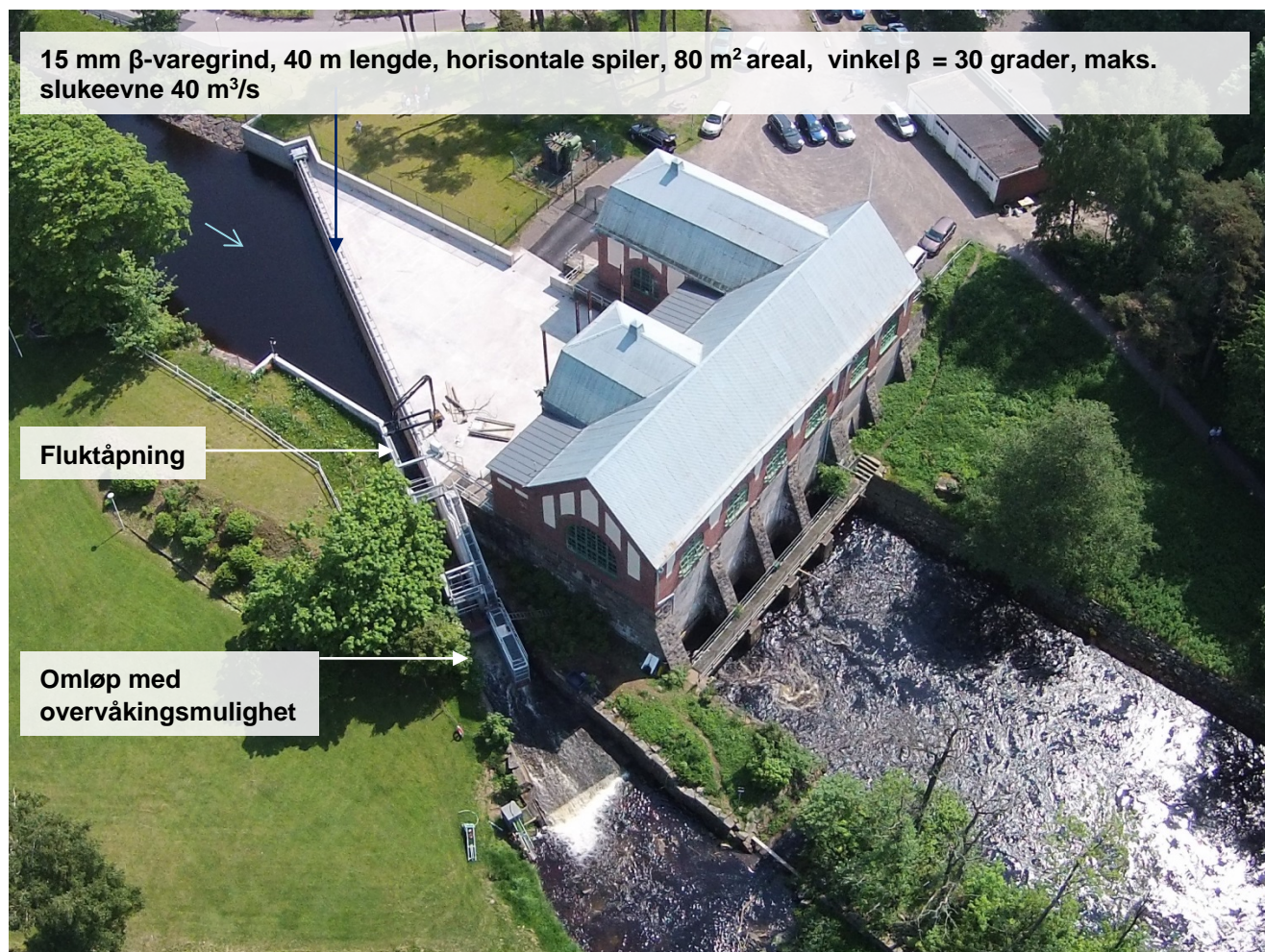
Figur 22 Vannkraftverk Herting i Ätran med beta-varegrind foran inntak, fluktåpning og omløp. Løsningen har meget gode resultater for nedvandring av blankål (95 %), laksestøinger (96 %) og laksesmolt (91-98 %, Foto: Fiskevårdsteknik AB, Sverige, med tillatelse, Calles m.fl. 2015, Nyquist m.fl. 2017).
