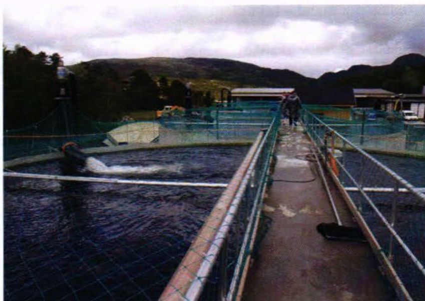
Figur 8-2 Oppdrettskar for laksesmolt med gjenbruk og CO 2 -fjerning fra vann. 20 – 50 % av avløpsvannet pumpes tilbake til karet igjen gjennom en lufter for fjerning av CO 2 og innmiksing av oksygen.
