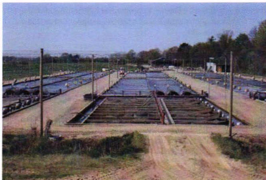
Figur 8-9 Oversiktsbilde over et dansk dambruksanlegg (Kongeåens Model Trout Farm) hvor man har tatt i bruk resirkuleringsteknologi for partikkelfjerning og biologisk filtrering av vannet. Anlegget har en årlig kapasitet på 1 000 tonn porsjonsørret (Jokumen & Svendsen 2010).
