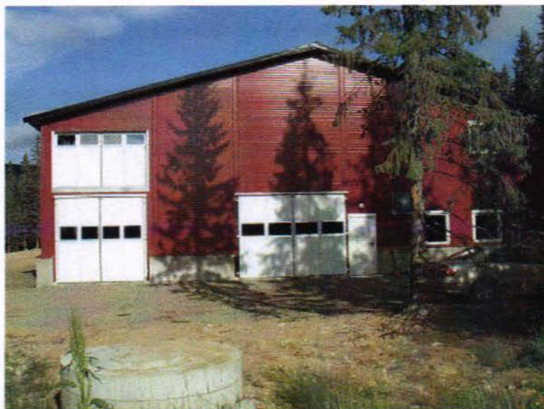
Figur 8-3 Resirkuleringsanlegg for røye. Slike anlegg blir ofte plassert innomhus for å unngå temperaturløstap til omgivelsene. Anlegget på bildet benytter seg av grunnvann, og grunnvannsbrønnen vises fremst i venstre hjørne.
