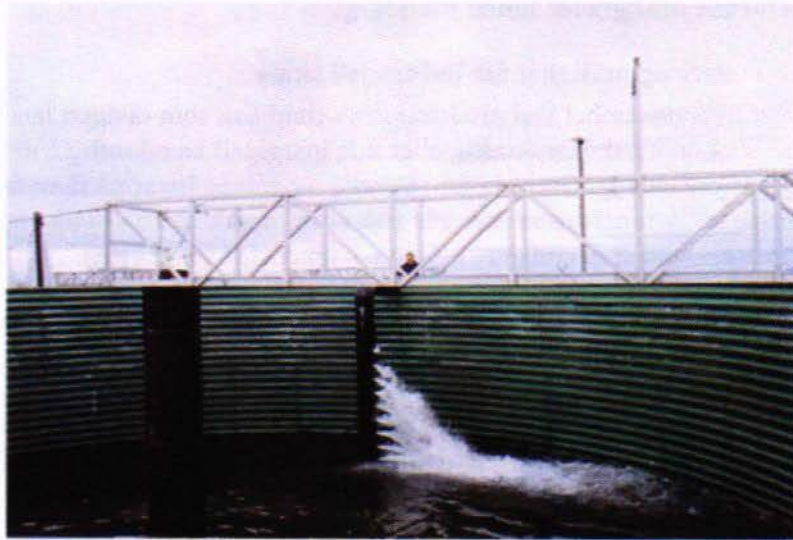
Figur 8-17 Oppdrettskar for røye på Island er langt større en hva som er vanlig hos norske fiskeoppdrettere. Karet på bildet rommer ca 2 000 m 3 vann, mens vanlig størrelse for oppdrettskar til innlandsoppdrett i Norge er 50 – 150 m 3 per kar.
