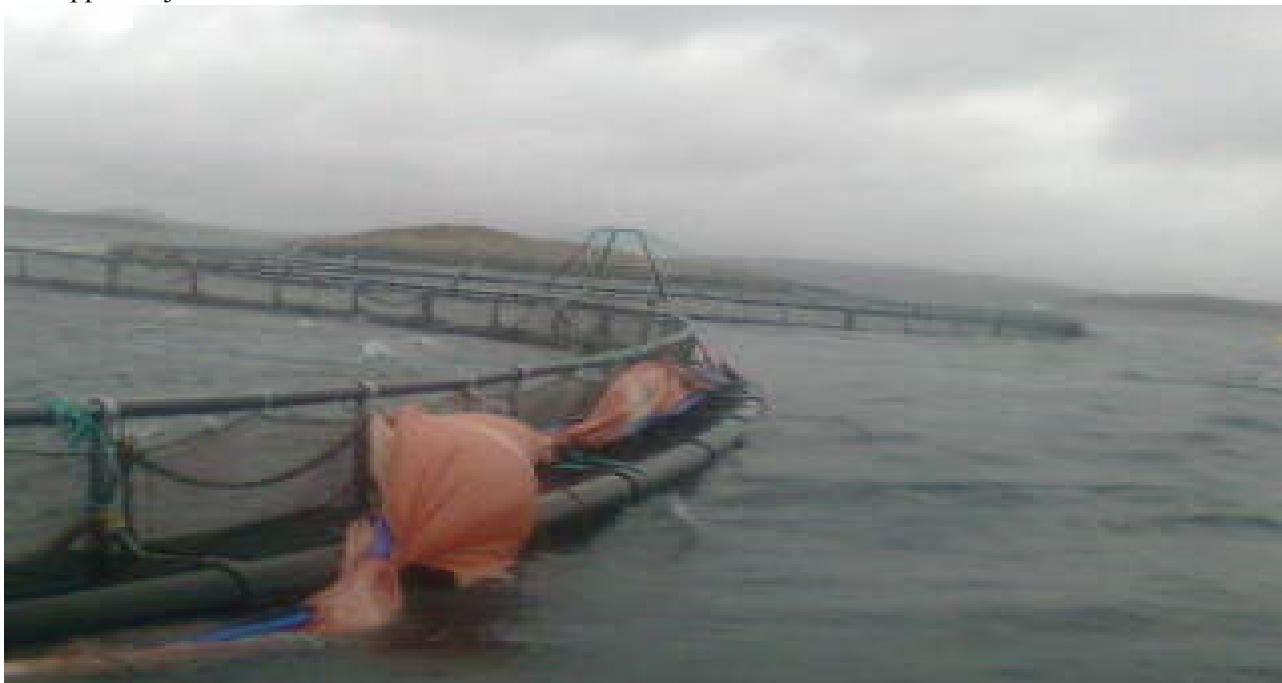
Figur 26. Skjørt kastet opp på flytekragen på lokalitet Helligholmen under storm september 2012.
