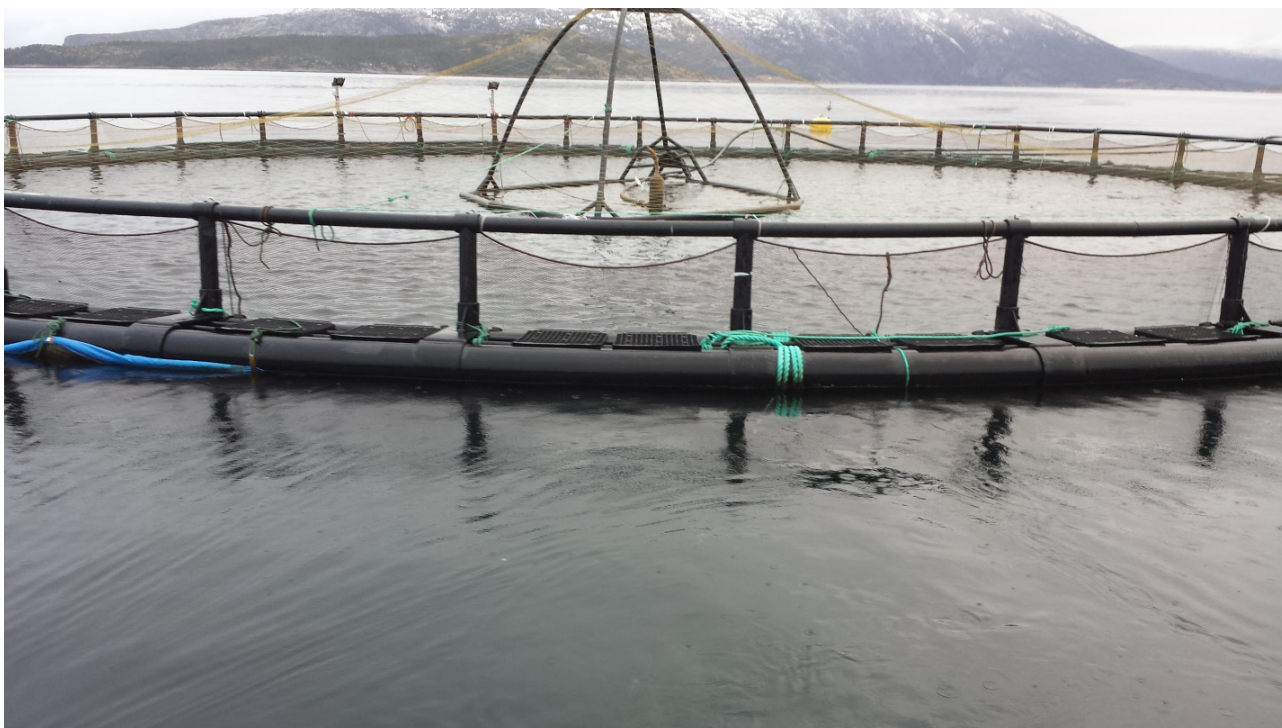
Figur 28. Skjørt montert innenfor ytterste flytering der båt vanligvis legger til på lokalitet Bjørkvik.
