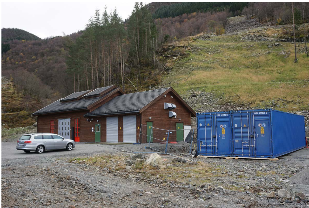
Figur 44: DIP LAB ved Ullestad og Tverråna kraftverk.
