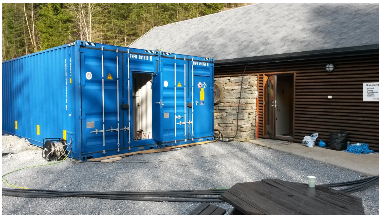
Figur 23: DIP LAB ved Bruvollkraftverk.
