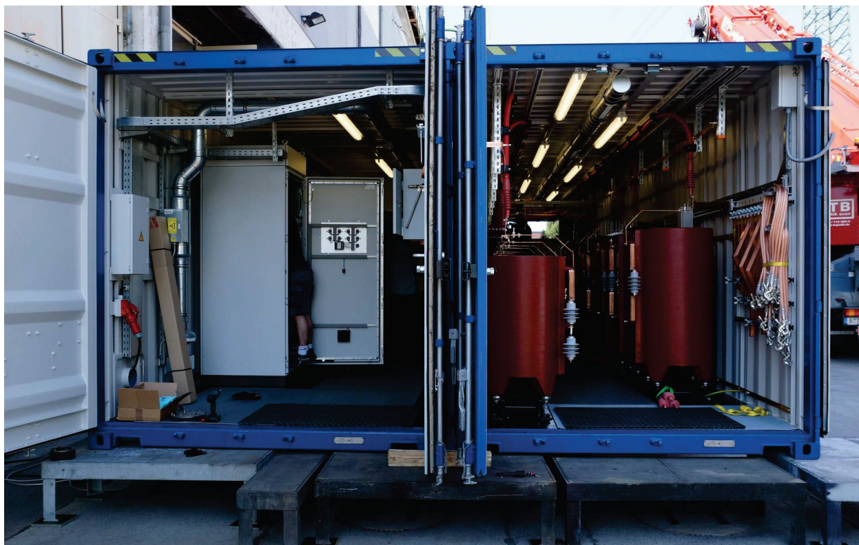
Figur 3. Bilde inn gjennom portene i begge konteinere som viser spolene (induktansene) i den ene konteineren (til høyre) og kontrollutrusningen i ytterste halvdel av den andre konteineren (til venstre).
