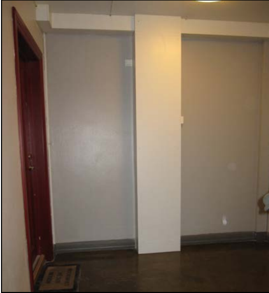
Fig. 79: Ny trasé for trykkvann – innkassing av rør i trappeoppgang
