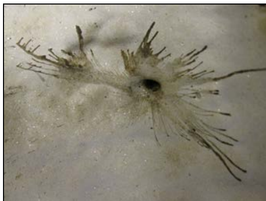
Fig. 60: Hull i belegg inklusive søylerør – kontroll utført i 2013
