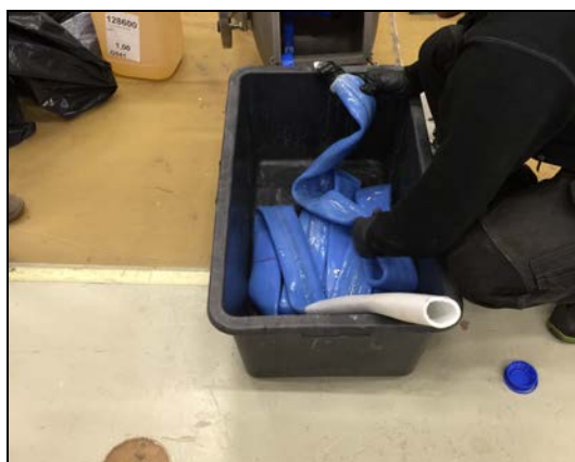
Fig. 10: Fyller strømpe med epoksy
