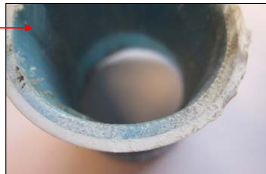
Fig. 56: Prøvestykke av Ø 50 mm relinet rør av ABS-plast – kontroll utført i 2014
