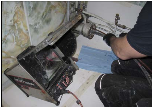
Fig. 21: Illustrasjon av videoinspeksjon av anlegg med inngang fra avløpsrør til klosett
