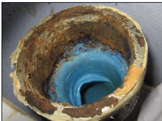
Fig. 57: Kontroll utført i 2012
