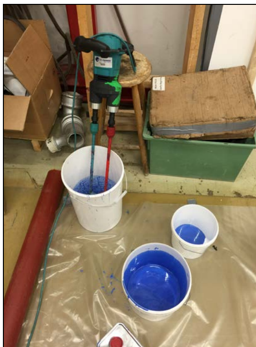
Fig. 9: Blanding av tokomponents epoksy
