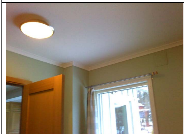
1. et.: trapperom, skillevegg mot kjøkken/yttervegg mot nordvest, etasjeskiller mot loft
