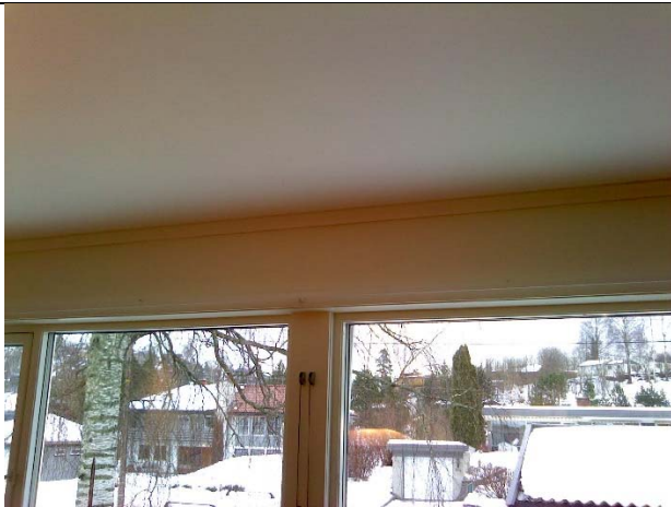
1. et.: stue, vinduer i yttervegg mot sørøst/etasjeskiller mot loft
