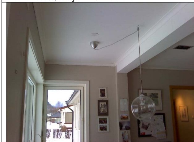
1. et.: kjøkken, tilbygg mot nordvest-nordøst/skillevegg mot trapperom/etasjeskiller mot loft
