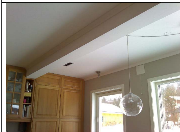
1. et.: kjøkken, tilbygg mot sørvest-nordvest/skillevegg mot stue/etasjeskiller mot loft
