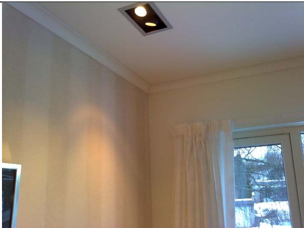
1. et.: stue, vinduer i yttervegg mot sørøst/yttervegg mot balkong/etasjeskiller mot loft
