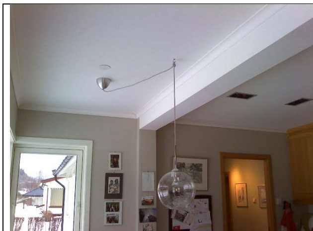
1. et.: kjøkken, tilbygg mot nordøst/skillevegg mot trapperom/etasjeskiller mot loft
