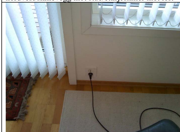
1. et.: stue, gulv/yttervegg og terrassedør mot sørvest
