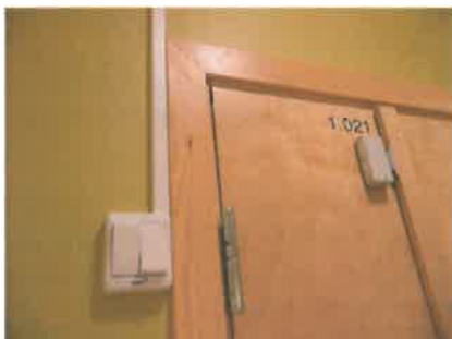
Figur 32 Doble brytere brukes for å låse opp døren
