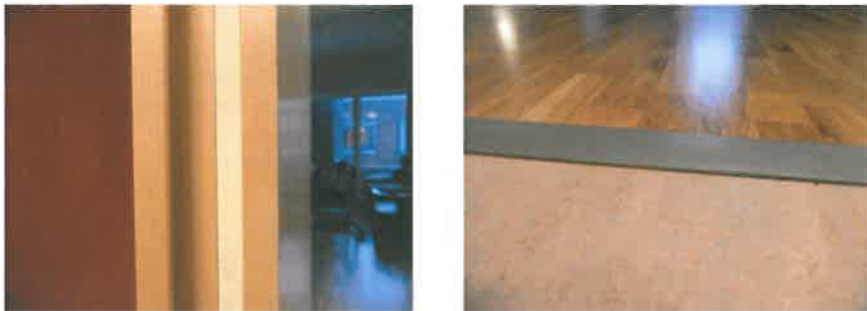
Figur 38 Hvert soverom er en brann-celle. Dørkanten ved gulvet er upraktisk for beboere og ansatte.
