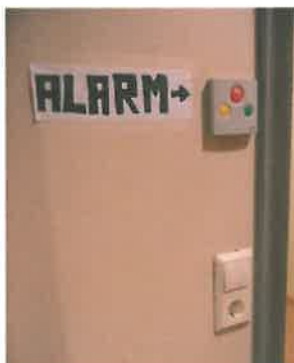
Figur 9 Alarm på rom til beboer som er plassert ved utgangsdøren. Lite tilgjengelig både for beboere og ansatte.
