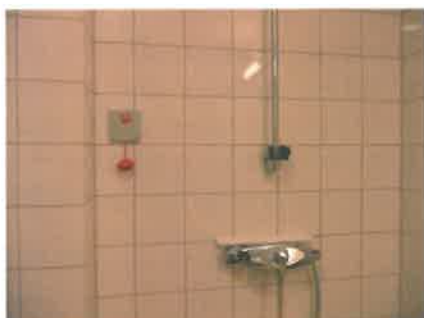
Figur 10 Snoralarm på bad mangler snor
