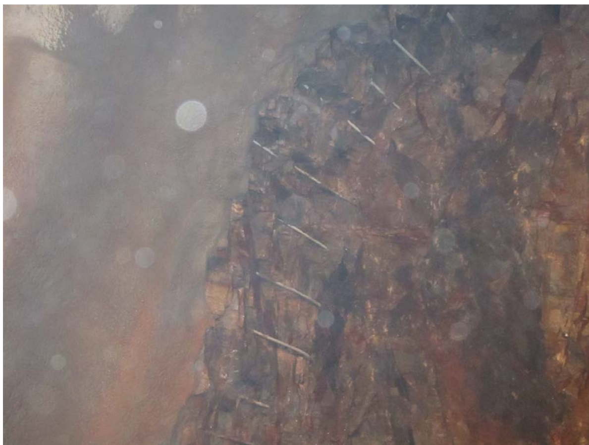
Fig.7 Ultrasing av svakhetssonemateriale til spilingboltene
