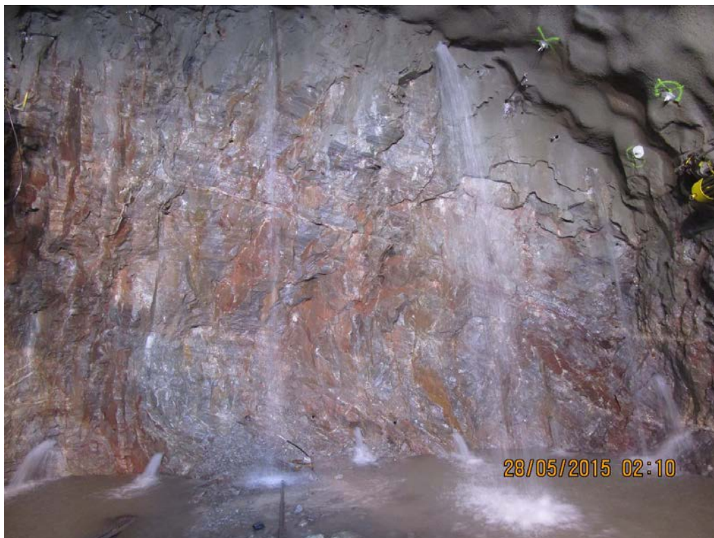
Fig.1 Ferdig boret injeksjonsskjerm, pel 14914
