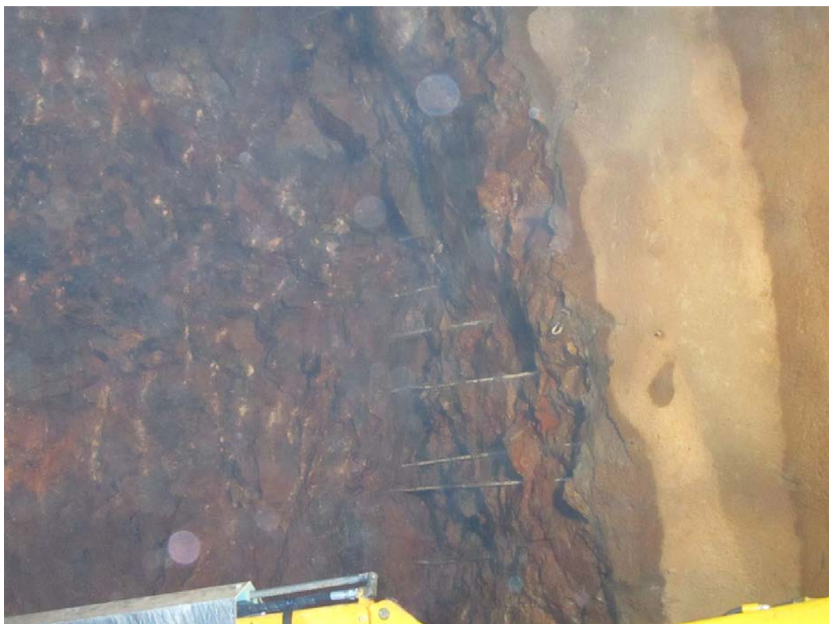
Fig.8 Utrasing av svakhetssonemateriale til spilingboltene
