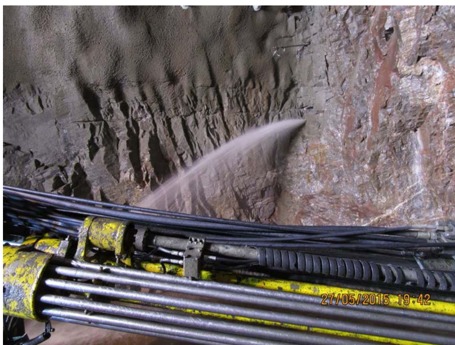
Fig. 6 Innlekkasje pel 14914
