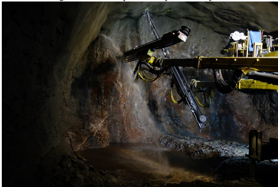
Fig.5 Innlekkasje pel 14914
