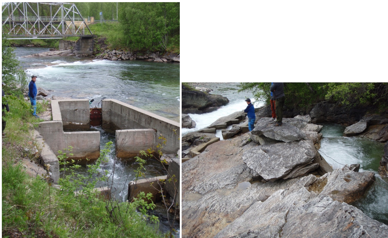
Figur 6. Øvre (til venstre) og midtre del av laksetrappa i Kistefoss.
