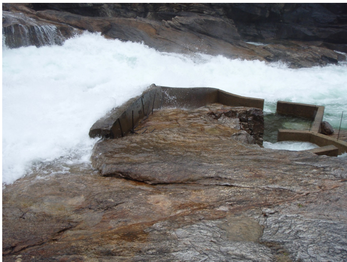
Figur 7. Øvre inngang til laksetrappa i Kistefoss.
