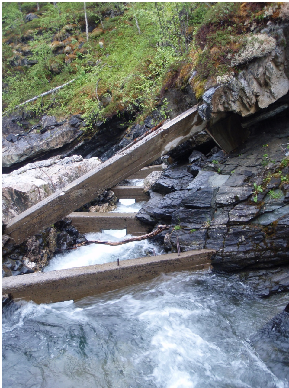
Figur 12. Trapp 2 i Langfossen er sprengt i berg og har terskler i betong. Kulpene er små. Berget er støttet opp med betongbjelker for å hindre utglidning.
