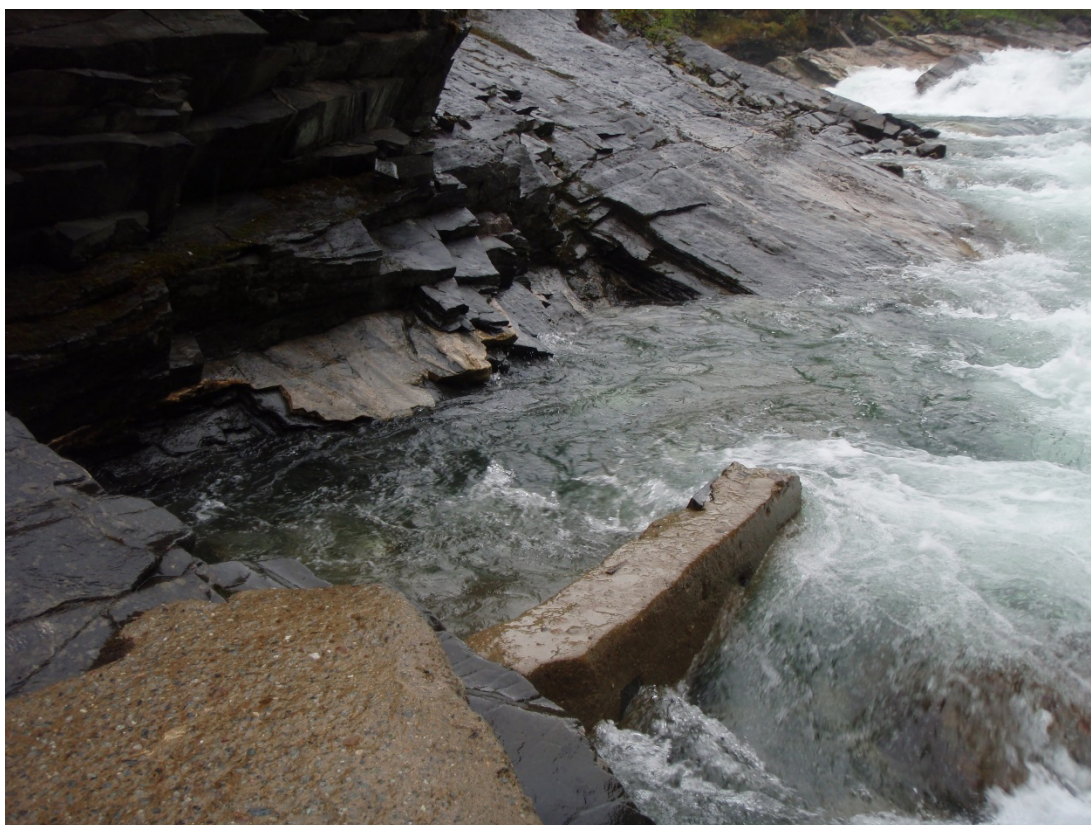
Figur 11. Utgangen av trapp 1 i Langfossen vises helt i venstre billedkant. Fisken må passere videre langs svaberget midt i bildet og videre opp til trapp 2 som vises så vidt i øvre billedkant.
