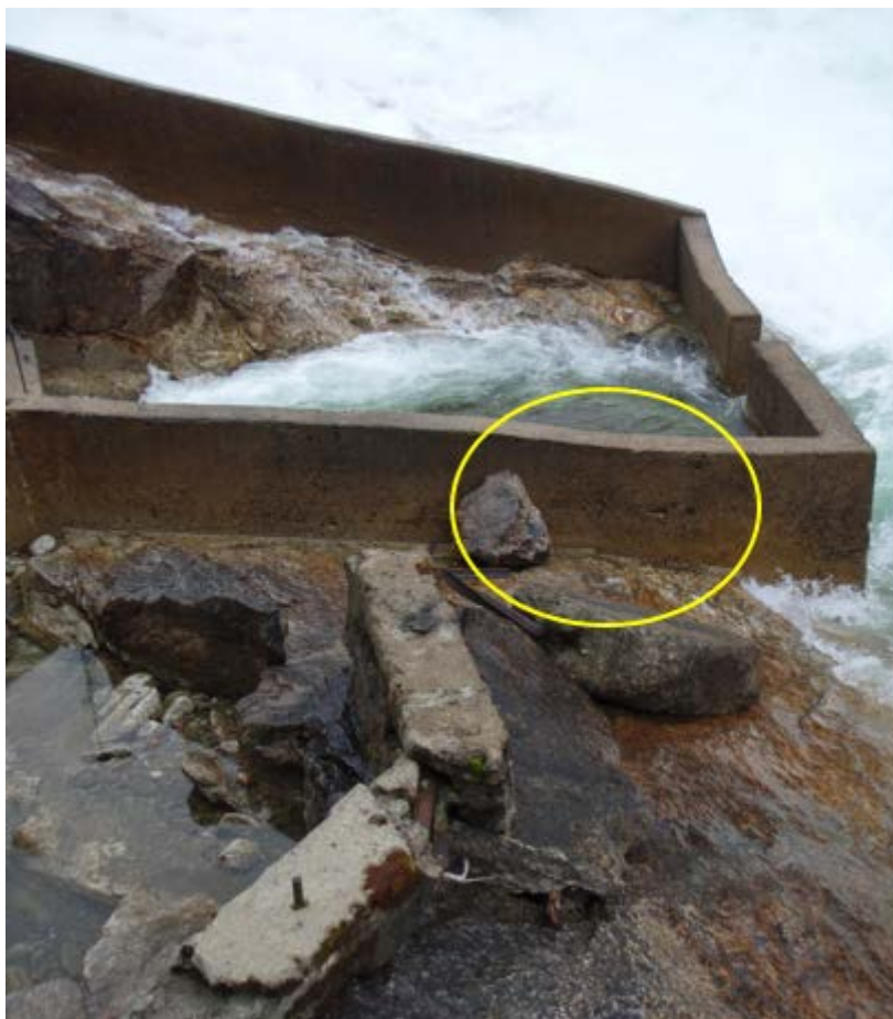
Figur 17. Plassering av ny inngang i laksetrappa i Kistefoss (øvre inngang) er foreslått med gul sirkel.
