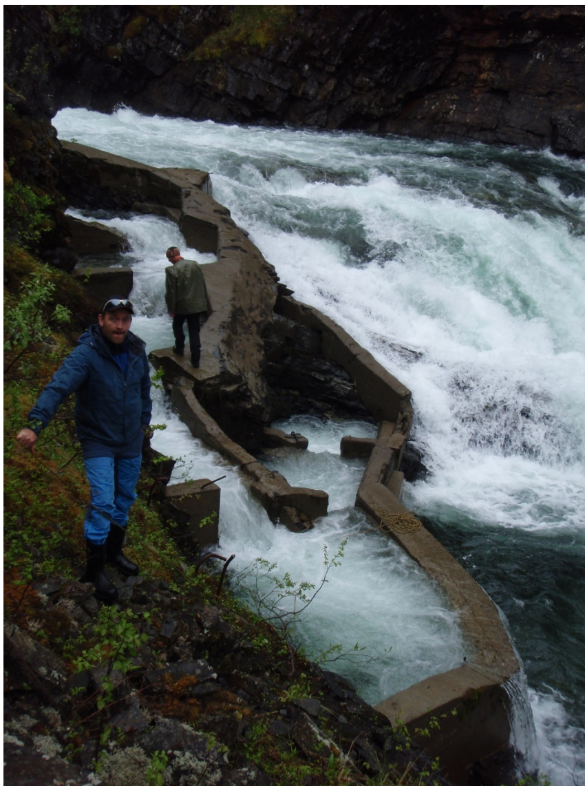
Figur 9. Den nederste laksetrappa i Langfossen, trapp 1.
