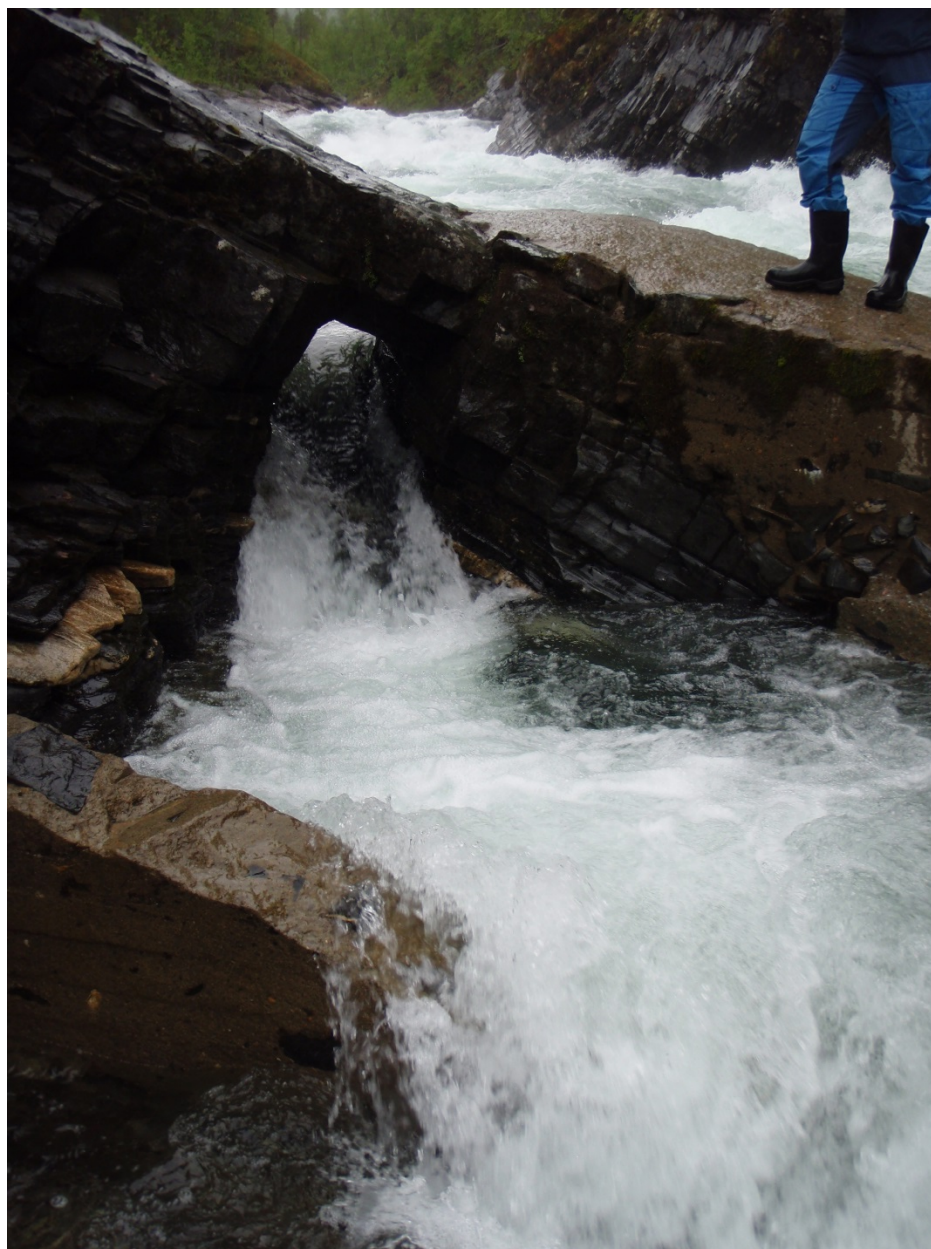
Figur 10. Vanninntak og øverste kulp i trapp 1.
