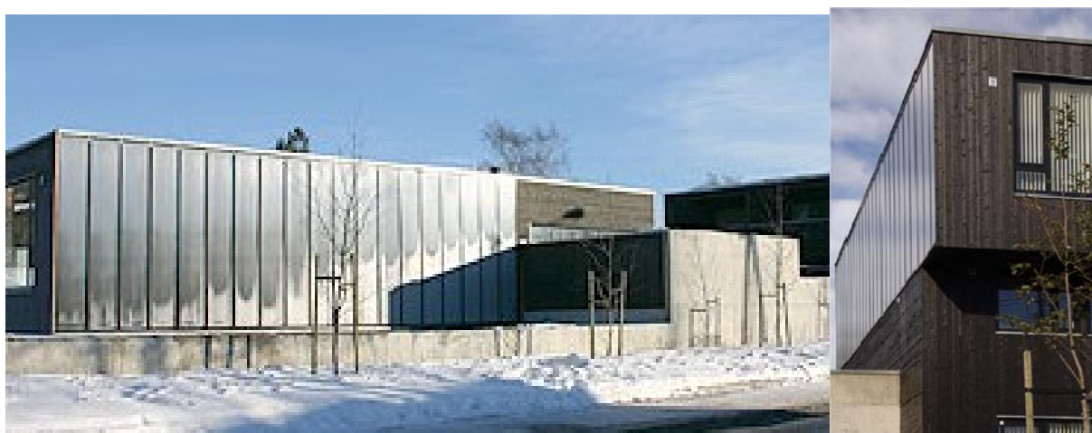
Figur 31: Solfangere i Bjørnveien 119 i Oslo (bilder fra www.backe.no og www.aventa.no ).
