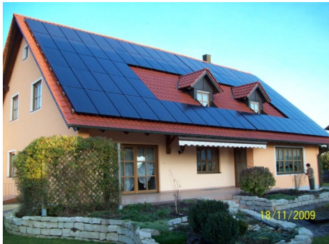
Figur 10: Solcelleanlegg montert på eksisterende tak [14].
