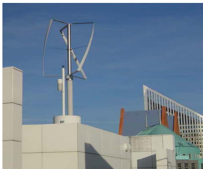
Fig. 5.3 Vindturbin plassert på tak. Kilde+ foto: http://www.turby.nl
