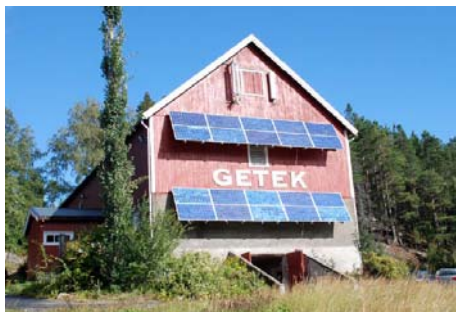
Fig 5.16 Bygning frakoplet el-nettet Kilde: www.getek.no
