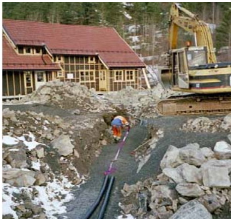
Fig 5.22 Rørgate i et nærvarmeanlegg. Kilde: www.Grip.no
