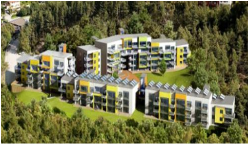
Fig 2.6 Passivhus. Blokkleiligheter. Løvåshagen i Bergen.
