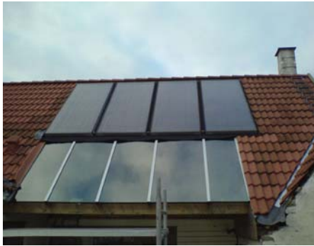
Fig 5.1 Termisk solfanger plassert på tak. Kilde: Ottawa Solar Power
