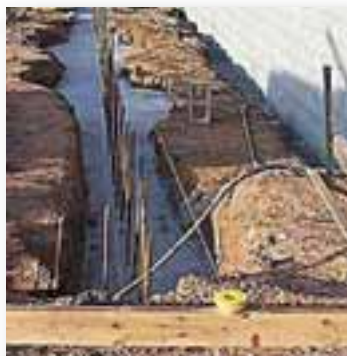
Fig. 17A: Spredte sålefundamenter.
