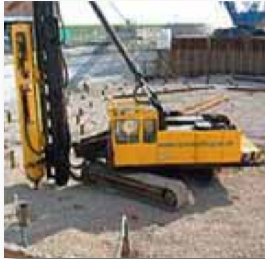
Fig. 18A: Nedramming av peler.
