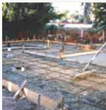
Fig. 17B og 17C: Plassering av betongplater på grunn (trinnvise).
