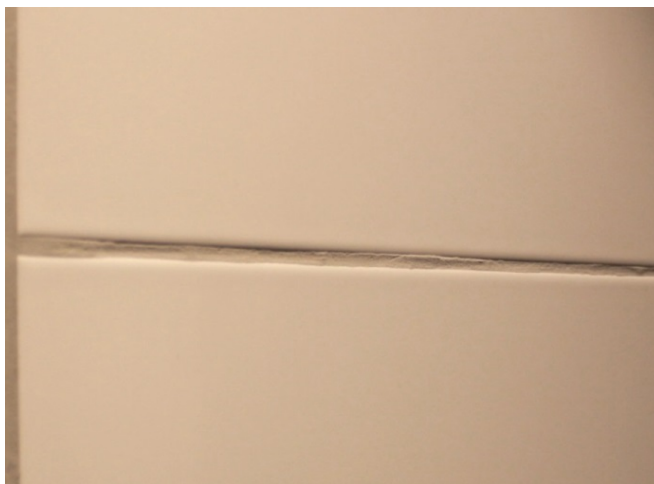
Figur 5: Fugens fyllingsgrad og jevnhet i overflaten er gjenstand for skjønnsmessig vurdering da ingen klare normer finnes.
