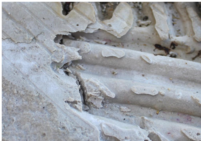
Figur 5: Dobbelliming med flytlim er alene ikke nok, flisen må presses ned så rillene flytter utover samt luften presses ut og ikke danner luftlommer.
