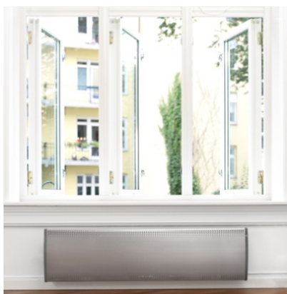
Figur 4.9 Varmelement plassert under vindu
