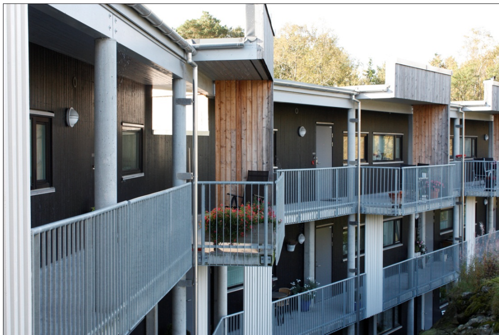
Utvidelser i svalgangen gir det nødvendige rommet for å ta den i bruk som uteplass.
