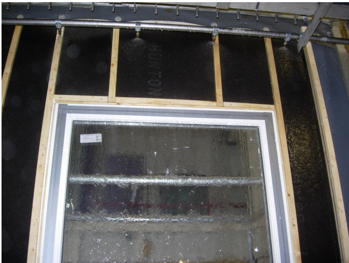
Figur 2.1. Et av prøvefeltene i slagregnskapet under prøving. Vindsperrestrimmel klemt med leker som tetting rundt vindu. Overgangen mellom karm og ramme er tapet da det er bare vindusinnsettingen som prøves.
