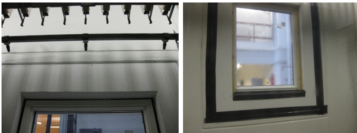
Figur 4.6.1. Fra prøving av regntetthet på vindu i murfelt. Til høyre prøving med regnskjerm rundt vindu.
