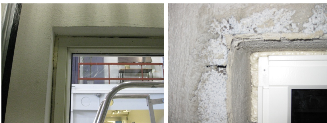
Figur 4.6.2. Polyuretanskum som tetting rundt vindu. Til venstre er vindu sett utenfra og til høyre innenfra.
