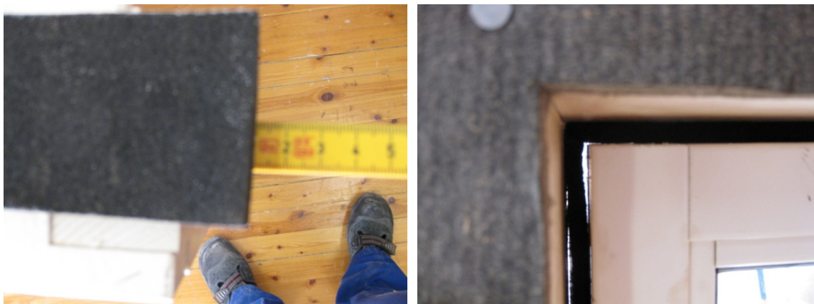
Figur 4.2.1. Montering av ekspanderende fugebånd som tetting rundt vindu. Fugebåndet monteres med overmåål i hjørnene for best tetting i fugen. Til høyre fugebånd rett etter montering før ekspansjon.
