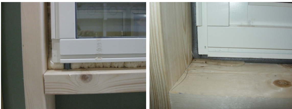
Figur 4.3.1. Polyuretanskum som tetting rundt vindu. Til høyre tetting med fugemasse mot bunnfyllingslist og inntregning av vann under prøving.
