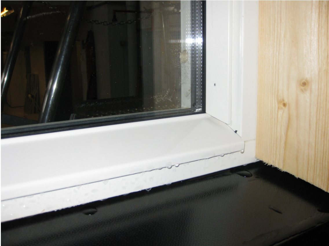
Figur 2.2. Et av prøvefeldene i slagregnskapet under prøving. Enkelte vindusløsninger ble prøvd med regnskjerm i form av sålebensbeslag og kledning rundt vindu.
