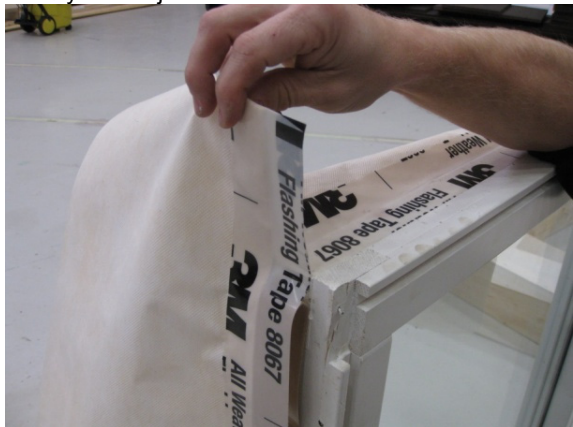
Figur 4.5.1. Butylmembran som tetting rundt vindu. Til høyre detalj fra underkant vindu.
