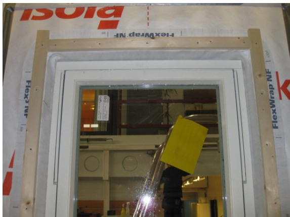
Figur 4.5.1. Butylmembran som tetting rundt vindu. Til høyre detalj fra underkant vindu.
