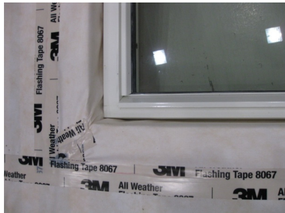
Figur 4.5.1. Butylmembran som tetting rundt vindu. Til høyre detalj fra underkant vindu.
