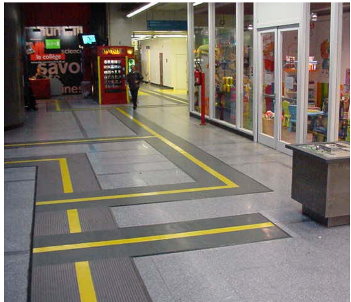
Fig. 47 og 48. Ledefelt i gummimateriale med innfelt ledelinje i kontrast. Oppmerksomhetsfelt har ledelinjen på tvers. Til høyre er et taktilt kart.
