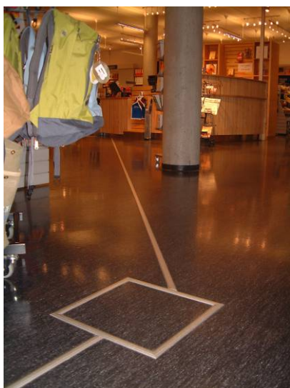
Fig. 62. Universitetet i Agder, Gimlemoen. Underordnet retning vises med en list. Eksemplet viser en ledelinje som treffer oppmerksomhetsfeltet i vinkel. Fig. 63: To parallelle lister markerer hovedretningen. Ledelinjen forholder seg til opprinnelig mønster i gulvet.
