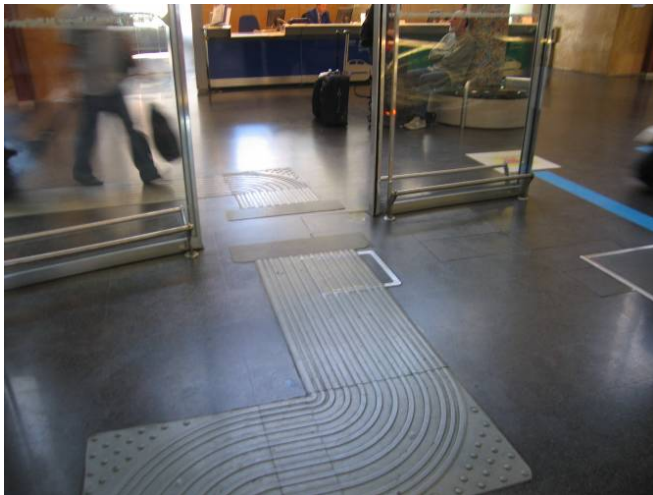
Fig. 39. Eget element for retningsendring, med riller i bue og knotter. Oppmerksomhetsfelt på begge sider av døren
