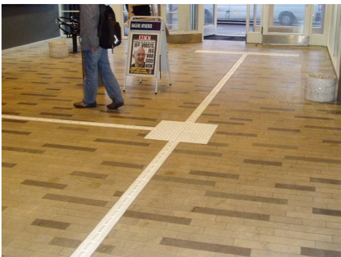
Fig. 69. Kalundborg banegård med hvitlakkerte stålfiser fra GH-form.
