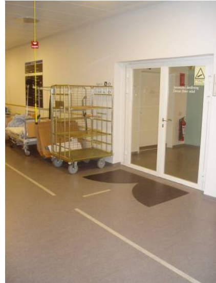
Fig. 68. Glostrup sykehus øyeavdeling, 2006. List med taktil og visuell kontrast. Åpent oppmerksomhetsfelt
