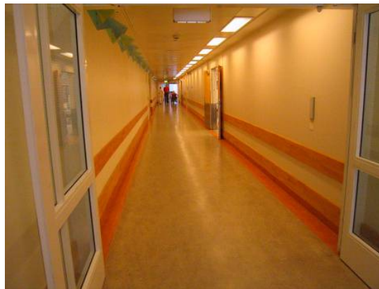
Fig. 28. Fender og høy gulvlist på Rikshospitalet, i tillegg til kantmarkering. Medplan arkitekter as.
