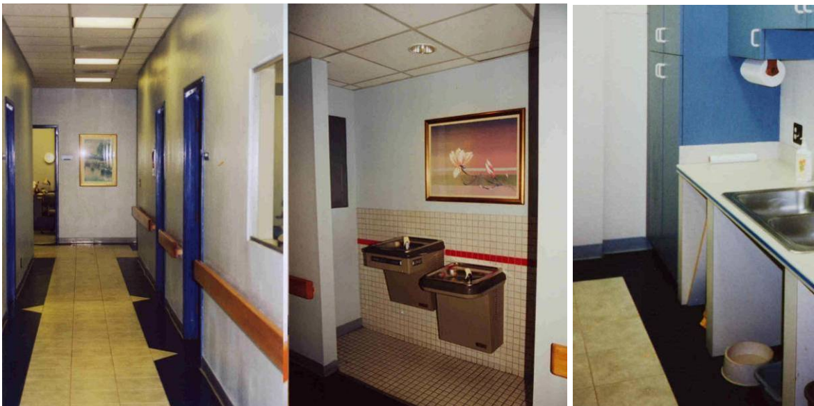
Fig. 15. San Diego Center for the Blind (Foto: Roberta Null) Kraftig markerte kontrastfargede ledelinjer. Til venstre med ledelinjer i gulvet kombinert med en taktil ledelinje, en håndlist på veggen. Linjene i gulvet har i tillegg markeringer ved dørene. Selv på toalettene og på kjøkken er systematikken gjennomført (bildet i midten og til høyre)
