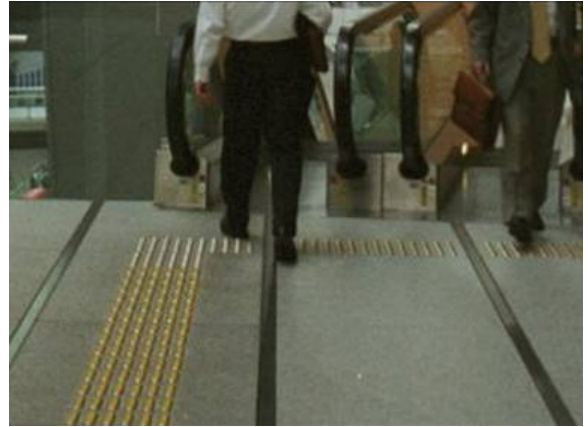
Fig. 11. Japanske ledelinjer av "knaster" festet på gulvbelegget. I begge situasjonene er det oppmerksomhetsfelt ved retningsforandringen. Det er også oppmerksomhetsfelt foran skranken på bildet til venstre og ved rulletrappa på bildet til høyre. Den skarpe gule kontrastfargen (til høyre) er vanligst, men utførelser i blankt stål brukes også. Det siste er utviklet for å samstemme bedre med fargevalg og materialer i moderne forretningsbygg. (Foto venstre: Ed Steinfeld)
