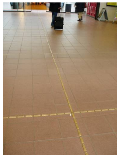
Fig. 70. Vejle trafikterminal med Pictoform elementer i bronse. Ingen oppmerksomhetsfelt i krysset.
