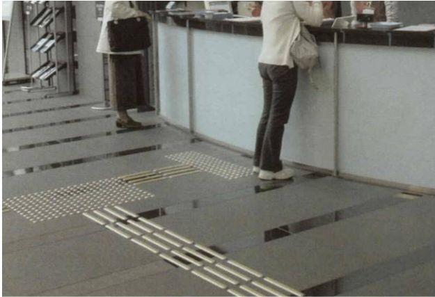
Fig. 11. Japanske ledelinjer av "knaster" festet på gulvbelegget. I begge situasjonene er det oppmerksomhetsfelt ved retningsforandringen. Det er også oppmerksomhetsfelt foran skranken på bildet til venstre og ved rulletrappa på bildet til høyre. Den skarpe gule kontrastfargen (til høyre) er vanligst, men utførelser i blankt stål brukes også. Det siste er utviklet for å samstemme bedre med fargevalg og materialer i moderne forretningsbygg. (Foto venstre: Ed Steinfeld)
