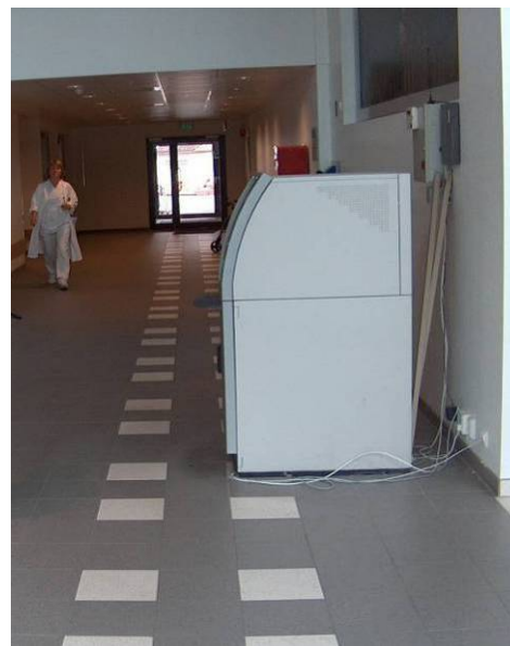
Fig. 51. Fare for sammenstøt på grunn av en feilplassert bankautomat.
