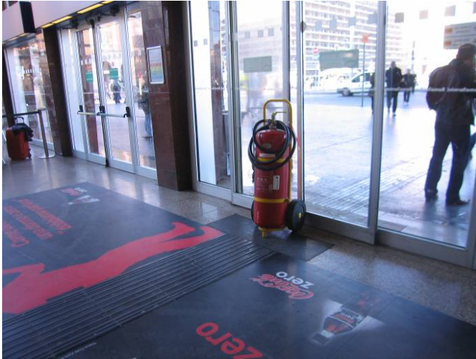
Fig. 37. Reklame på gulvet reduserer kontrasten og plassering av rengjøringsmateriell hindrer bruker av ledelinjen ved hovedinngangen
