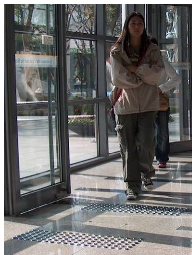
Fig. 71. Oppmerksomhetsfelt av stålknaster foran hovedinngangsdør på Severance hospital i Seoul
