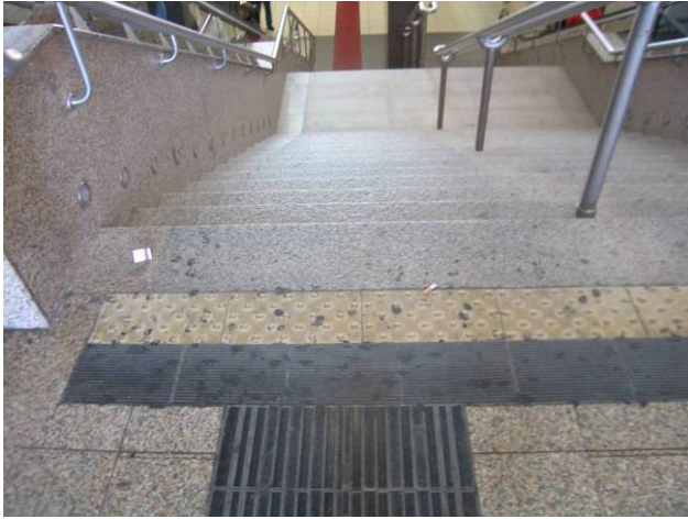
Fig. 73. Kombinasjon av oppmerksomhetsfelt med riller og varselfelt med knotter ved toppen av trappen. Roma Termini.
