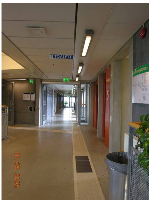
Fig. 72. Ingvar Kamprad Designcentrum, Lund tekniska högskola, ferdigstilt i 2002. (Gunilla Svensson arkitektkontor). Foto: BAS. Fellesarealene er planlagt med ledelinjer. Disse består av 3 rader med relieff-fliser som er lagt i terrassogulv. Ledelinjen er kantet med smale felt av slett flis. Bildet til høyre: Oppmerksomhetsfelt med slett flis i sterk kontrast mørk grå/offwhite markerer stedet korridoren starter.
