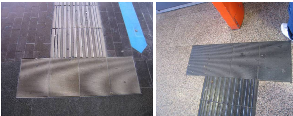
Fig. 64 og 65. Oppmerksomhetsfelt og ledelinje i kontrast til gulvbelegget. Roma Termini.
