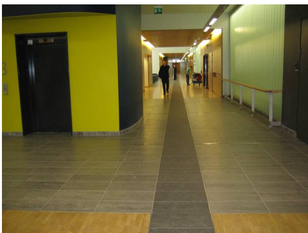
Fig. 42. Hovedretningen er markert med bred linje i naturstein, med god kontrast til øvrig gulv.
