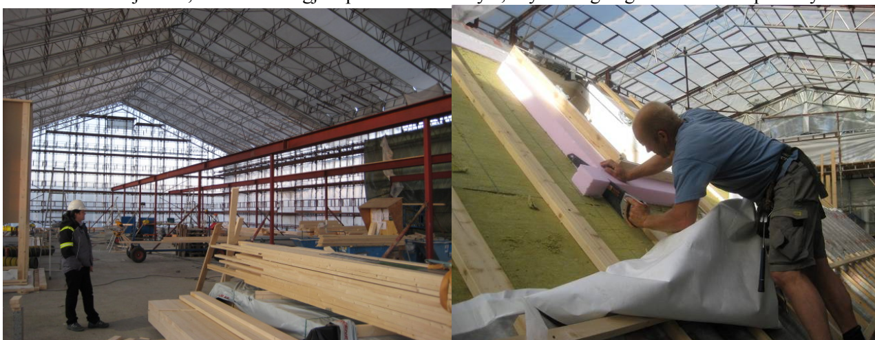
Figur 104 Bygging under telt: Storøya og Skøyen. Foto: HENT as og Stein Stoknes.
