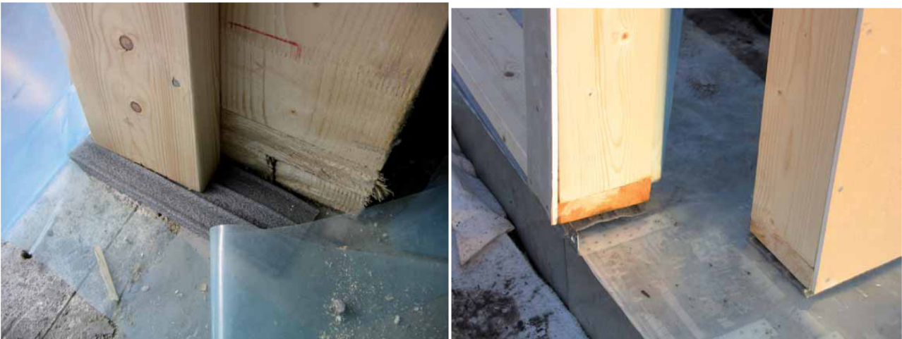
Figur 84 Firemannsboliger i Frillesås (t.v.) og enebolig i Lidköping (t.h., under høyre stender): Fuktbeskyttelse med profil av skumplast (Ulla Jansson).
