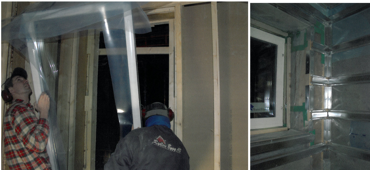
Figur 80 Monteringsklar vindu med remser (t.v.) og krysslekting med stålprofiler på badveggene (Brosjyre fra Passivhuscentrum).
