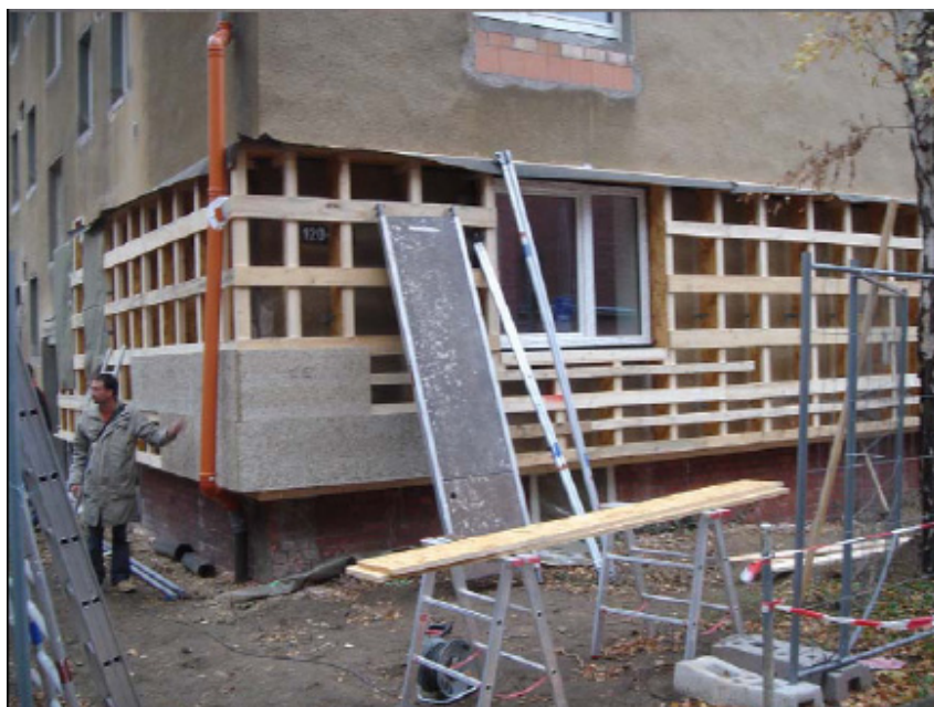
Figur 62 Fasadekonstruksjonen på byggeplassen (IWU).
