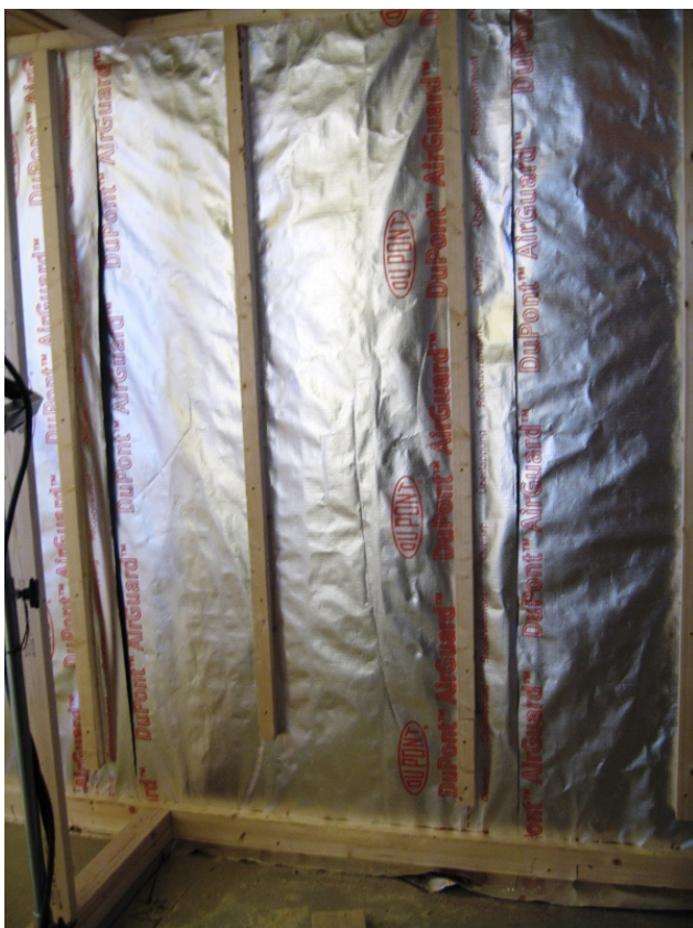
Figur 20 Varmereflekterende, inntrukket dampsperrer Teknisk Godkjenning 20004 Air Guard
