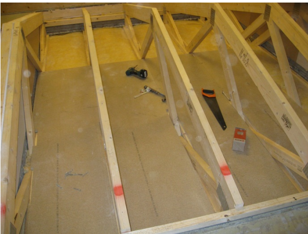
Foto av tak 3.4. Ekstra isolert loftgolv
