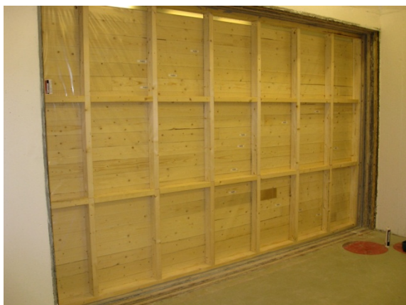
Foto av vegg 1.1. Bindingsverk og innvendig panel
