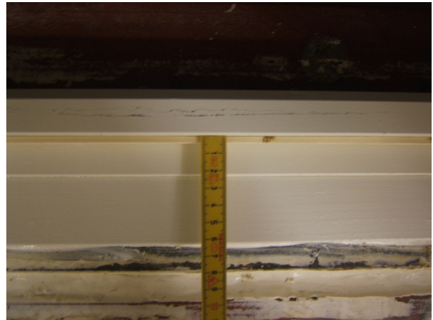
Foto 2.3.13. Natre H-vindu (toppsving). Detalj av trelist (4 mm) som erstatning for pakning
