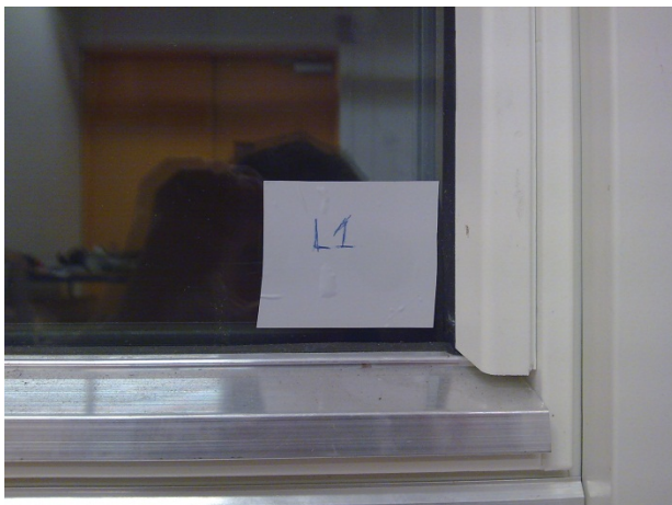
Foto 2.3.7. Vindu L1 sett fra utsiden i lukket tilstand
