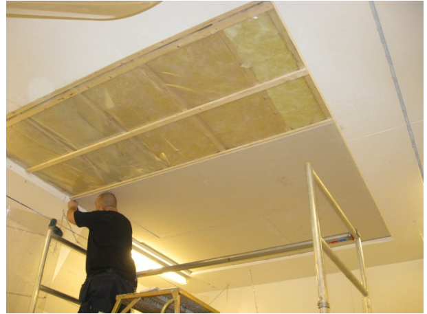
Foto av tak 3.1. Himling
