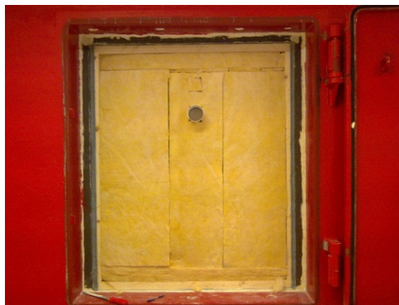
Foto 4.3.13. Innbygging av Fresh Z-dB i 200 mm vegg med mineralull, ferdig isolert
