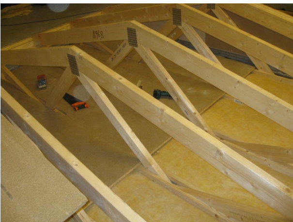
Foto av tak 3.4. Ekstra isolert loftgolv
