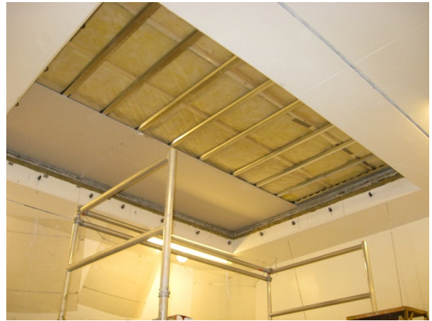
Foto av tak 1.4. Nedlektet lydhimling
