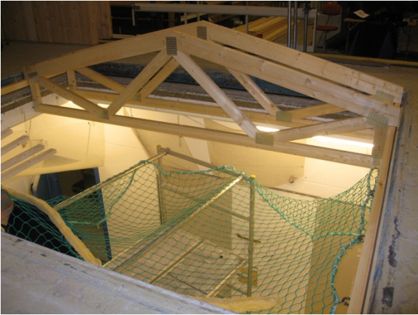
Foto av tak 3.1. Takstolmontering
