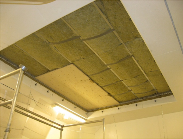
Foto av tak 1.6. 22 mm kryssfiner til stålprofiler
