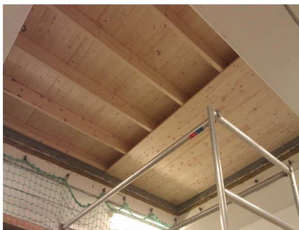
Foto av tak 4.1 Sperrer og panelhimling.
