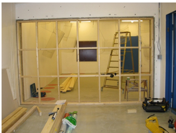
Foto av vegg 1.1, bindingsverk
