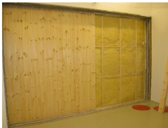
Foto av vegg 2.1. Innvendig 15 mm panel
