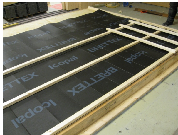
Foto av tak 2.1. Brettex, sløyfer og lekter.
