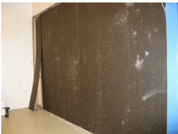
Foto av vegg 2.1. Vindsperre (Asfalt vindtett)
