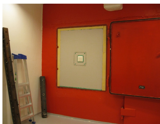
Foto 4.1.2. Avblendet vindusåpning med veggventil montert sett fra senderrommet
