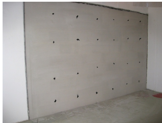
Foto av vegg 3.5. Fastskruing, 24 stk av Leca-vegg
