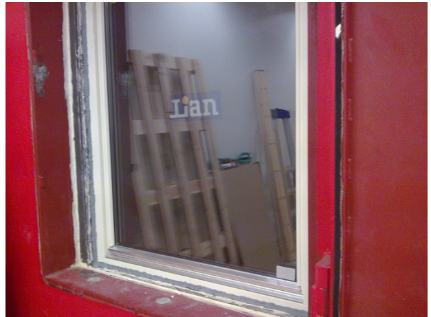
Foto 2.3.6. Vindu montert i prøveåpningen sett fra klangromssiden
