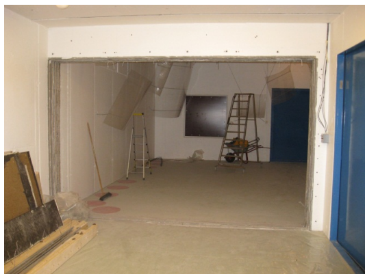
Foto A1. Prøveåpning for ytterveggmålinger
