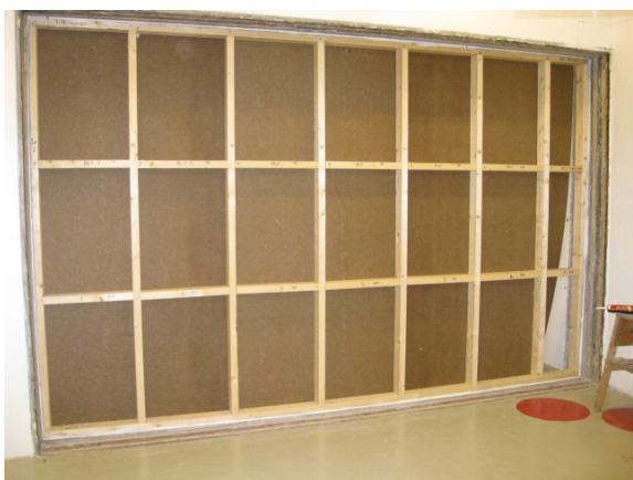
Foto av vegg 2.1. Bindingsverk og Asfalt vindtett
