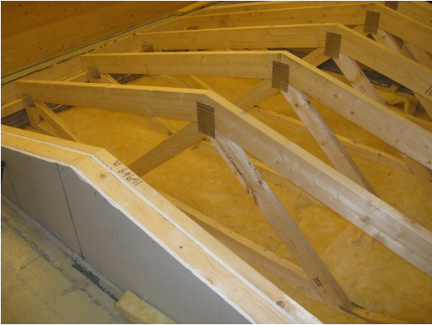
Foto av tak 3.4. Ekstra isolert loftgolv
