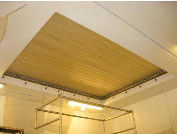
Foto av tak 1.1. 15 mm panelhimling
