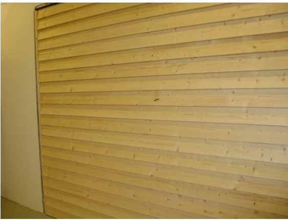
Foto av vegg 3.1. Utvendig kledning
