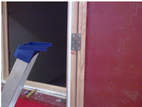
Foto 2.3.1. Koblet vindu (4-40,5-4) i prøveåpning
