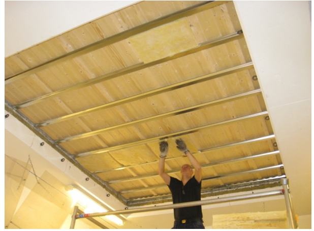
Foto av tak 1.4. Nedlektet lydhimling
