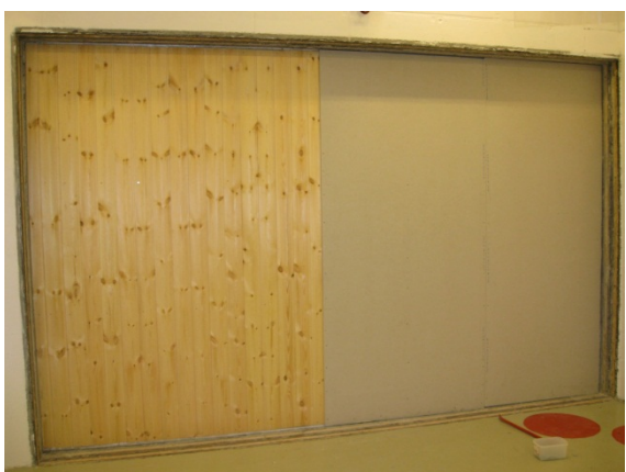
Foto av vegg 2.2. Ekstra innvendig gipsplate
