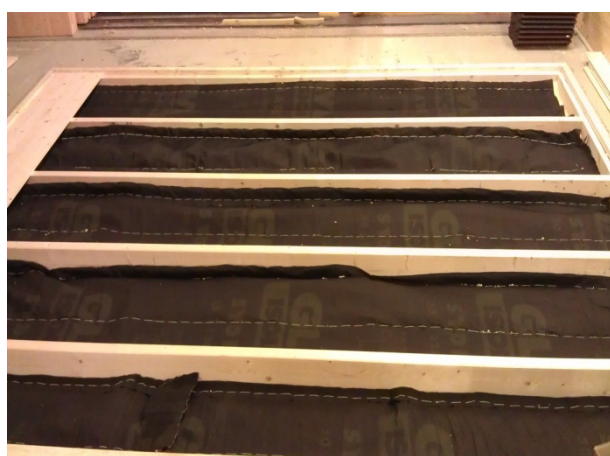
Foto av tak 4.3 og 4.4. Sydd matte (isolasjon)
