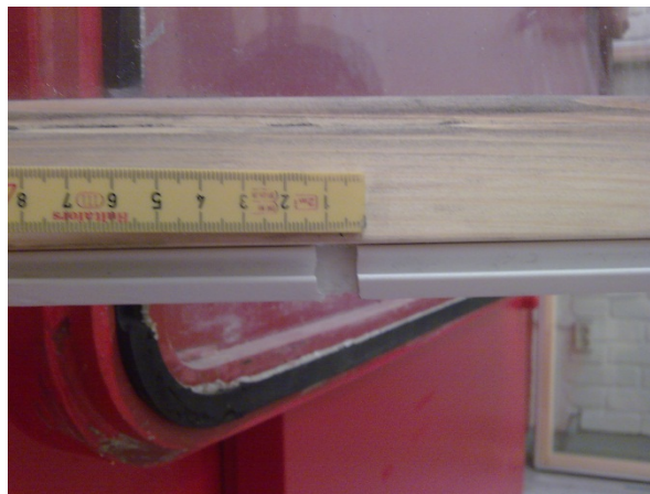
Foto 2.3.2. Detalj av spalter i pakning
