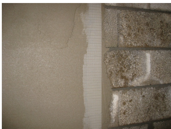
Foto av vegg 3.5. Fiberarmert puss på Leca-vegg
