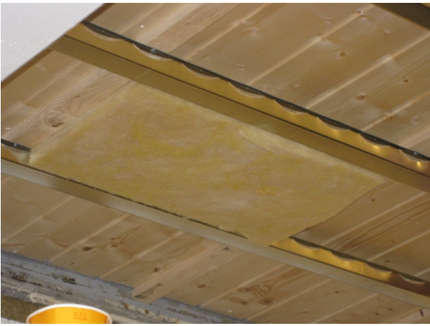
Foto av tak 1.4. Nedlektet lydhimling
