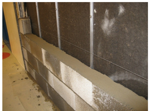
Foto av vegg 3.5. Utvendig 150 mm Leca forblending
