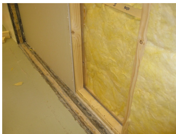
Foto av vegg 2.3. Innvendig frittstående tilleggsvegg
