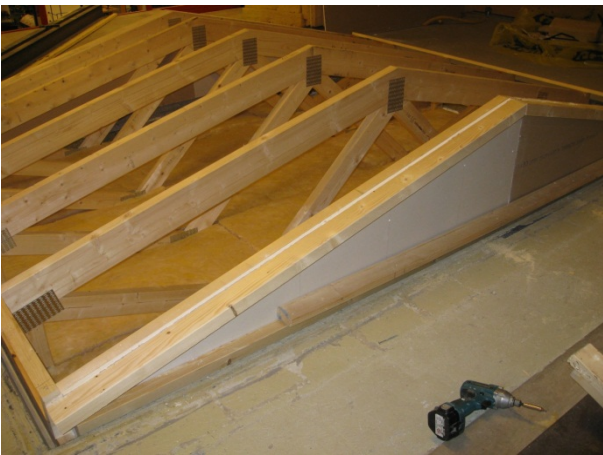
Foto av tak 3.1. Dobbel, isolert gipsplatevegg i ende
