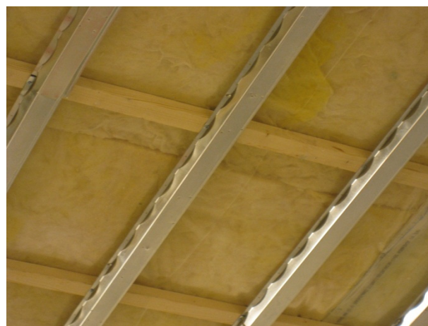
Foto av tak 2.2. Gyproc akustikkprofil.
