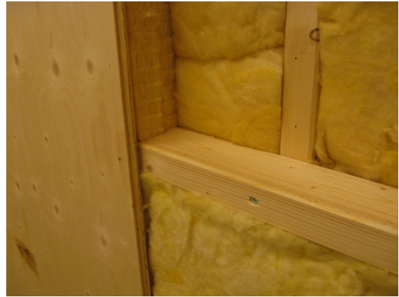
Foto av vegg 3.4. Utvendig tverravstivet vegg
