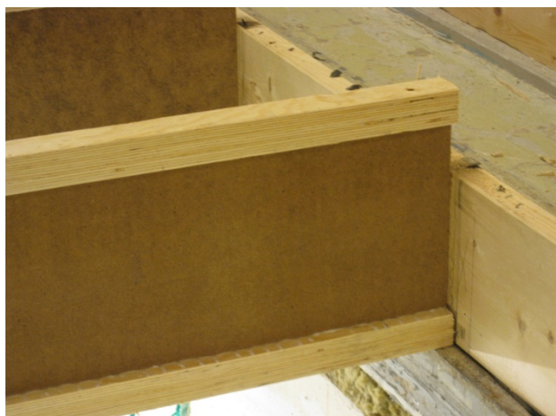
Foto av tak 2.1. 300 mm I-bjelker.
