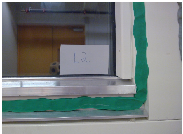
Foto 2.3.8. Vindu L2 med kunstig tetting over spalte mellom karm og ramme og over monteringsfuge.
