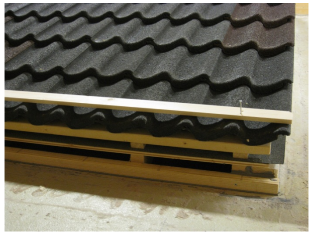
Foto av tak 3.1. Takstein, sløyfer, lekter, lufteåpning
