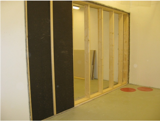
Foto av vegg 3.1. Bindingsverk og Asfalt vindtett
