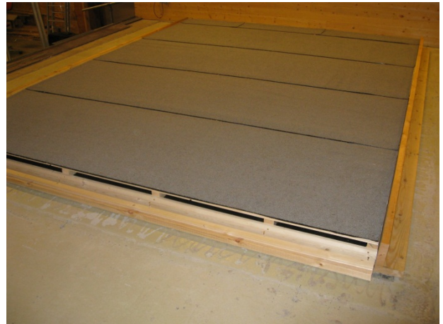
Foto av tak 1.2. Tekking med asfaltpapp
