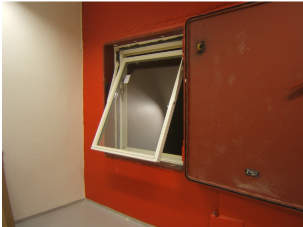
Foto 2.3.11. Natre H-vindu (toppsving) montert i lydlaboratoriet (sett fra senderrommet)
