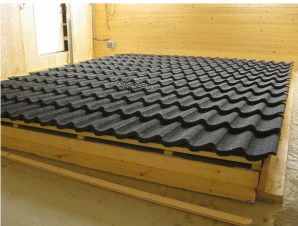
Foto av tak 1.1. Takstein
