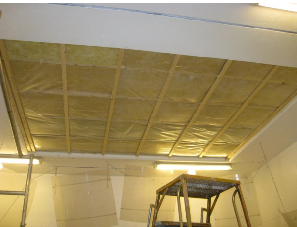
Foto av tak 3.1. Himling
