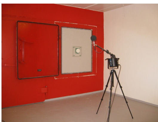
Foto 4.1.1. Avblendet vindusåpning med veggventil montert sett fra klangrommet
