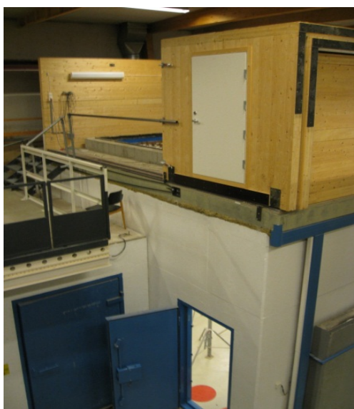
Foto A4. Senderrom/teleskophus (åpen stilling) og klangrom
