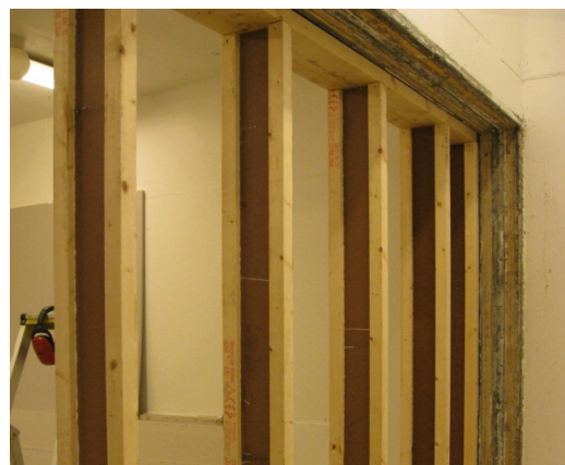
Foto av vegg 5.15.1. Stendere av 200 mm I-bjelker
