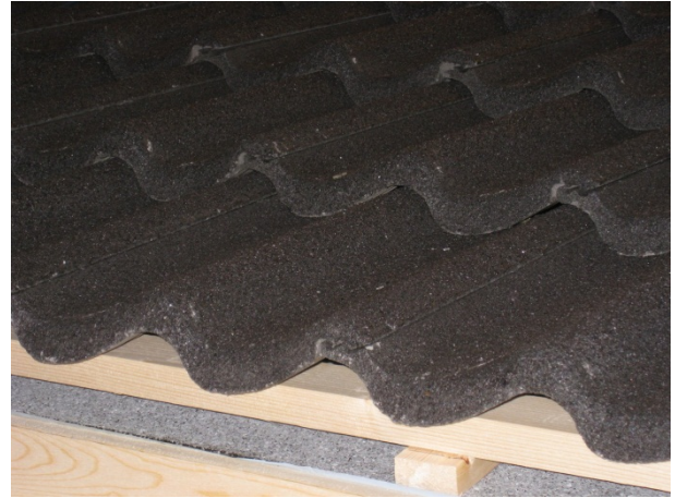
Foto av tak 1.6. Taksteinl lekter, sløyfer.
