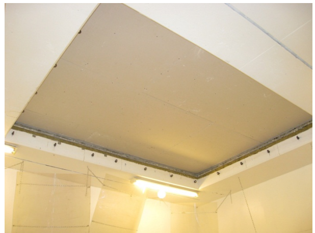
Foto av tak 1.4. Nedlektet lydhimling, ferdig.
