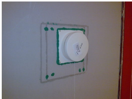
Foto 4.3.6. Eksempel på én type innvendig ventil (ventil A for ventiltype Fresh 80 dB)
