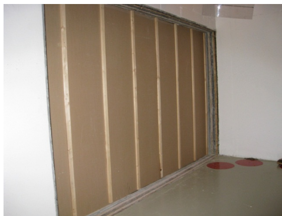
Foto av vegg 1.4 og 1.6. Utlektning og utvendig panel
