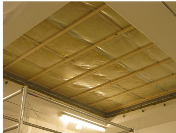
Foto av tak 2.1. Lekter underside.
