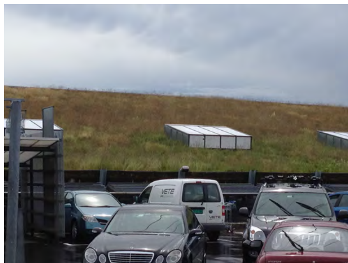
Taket på Alna senter sett fra parkeringsplassen. Foto: ILP/UMB
