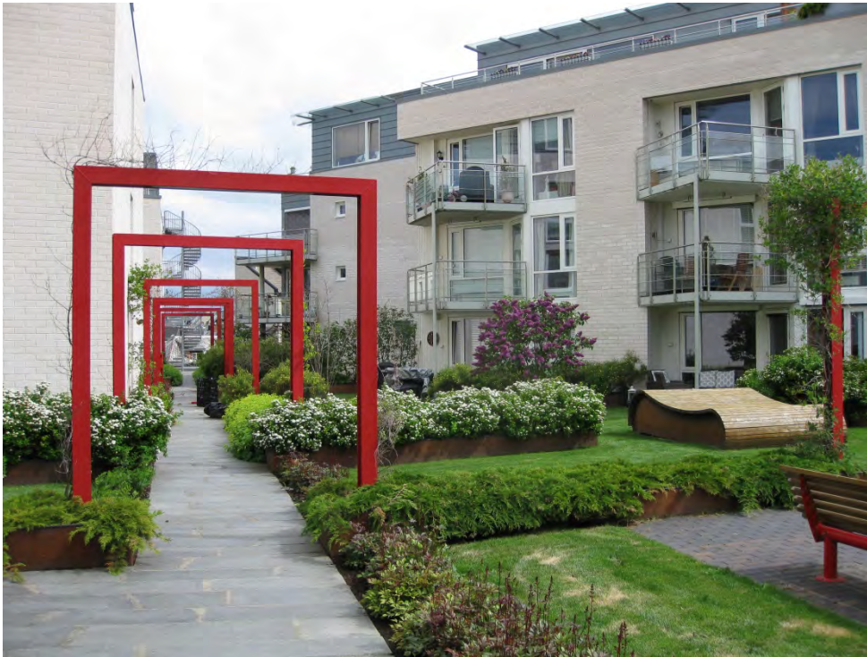
Figur 3.6. Eksempel på intensivt grønt tak med varierende vekstlagstykkelser i forhold til behovene til beplantningen. Foto: SINTEF Byggforsk
