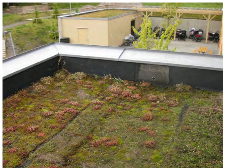
Parapet med nødoverløp. Foto: SINTEF Byggforsk
