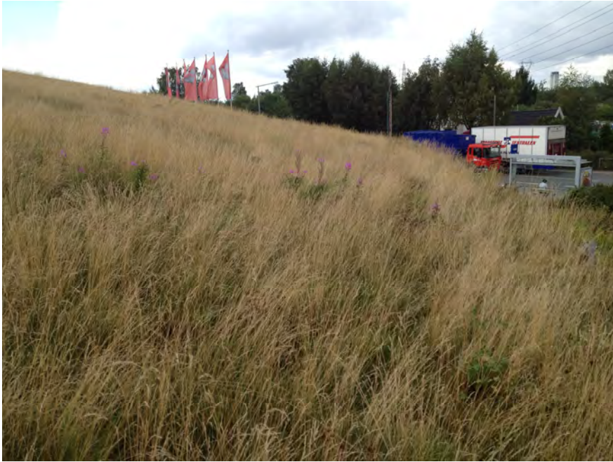
Figur 3.5. Eksempel på semi-intensivt tak med torv. Foto: UMB/ILP
