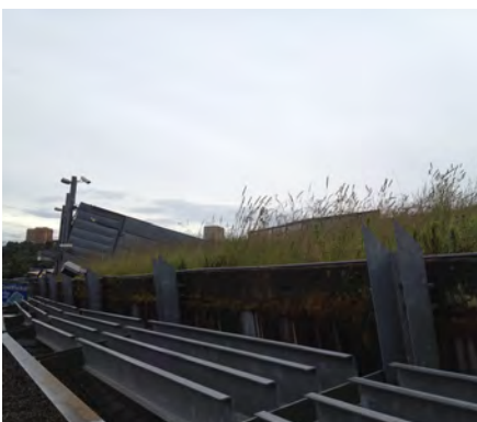
Nedre kant, med stålkonstruksjon, utenfor
