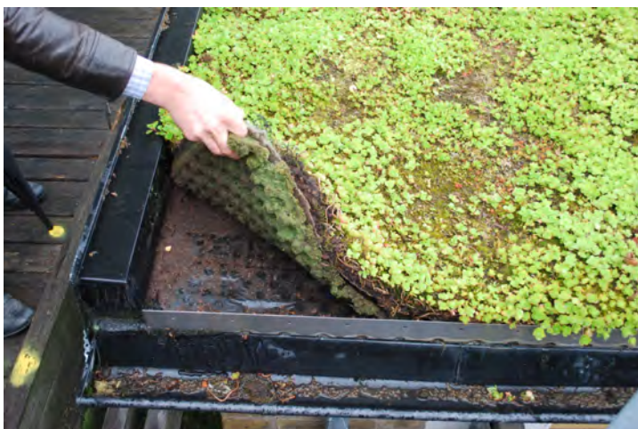
Fig. 5.2 Vekster, vekstmedie, fuktbevarende lag og drensag fra Augustenborg botaniske takhage 2010 (Foto: ILP/UMB)
