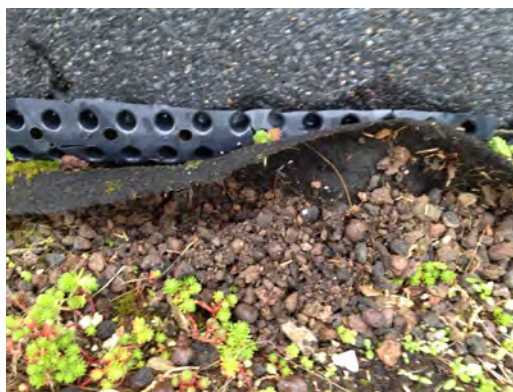
Oppbygging m knåsteplate, filtduk og lavestein og lett-klinker. Foto: ILP/UMB
