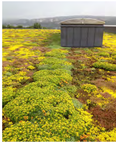
Striper av sedum over renner Foto: ILP/UMB
