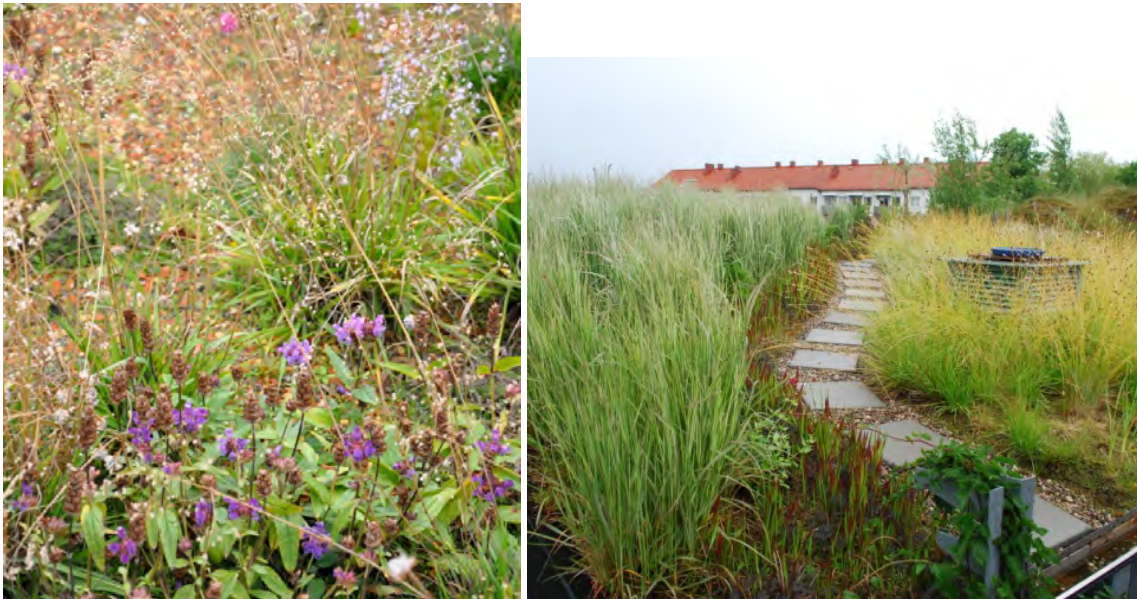
Fig. 5.6 Semi-intensivt tak på Riksarkivet, København 2010 (venstre), og på Augustenborg bot. Takhage 2010 (høyre) Foto: ILP/UMB
