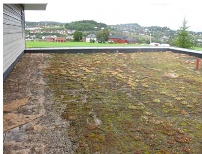
Taket over barnehagen. Foto: SINTEF Byggforsk
