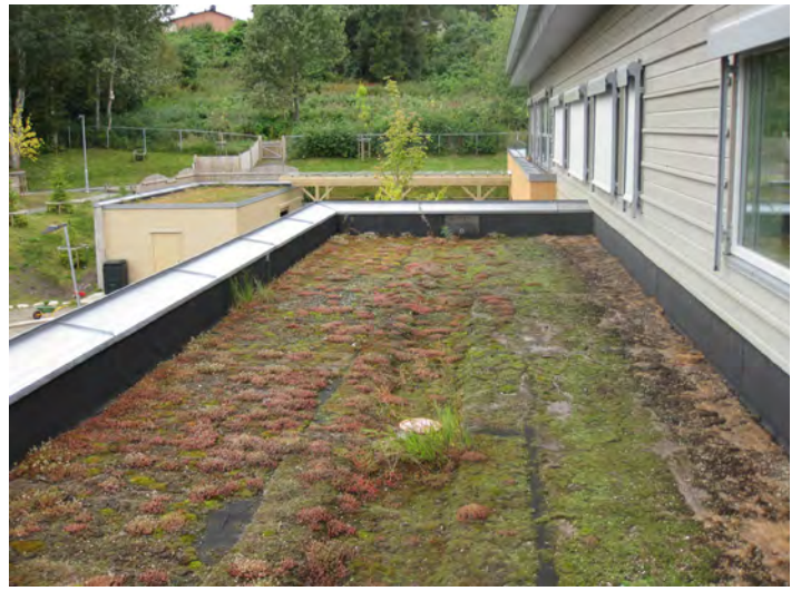
Foto: SINTEF Byggforsk
