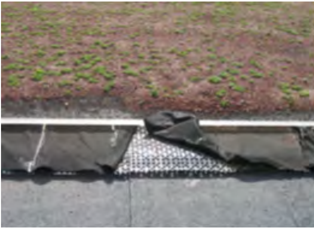
Oppbygging av sedumdekket oppå asfalttakbelegget, «nysådd». Foto: Gåsa ark.
