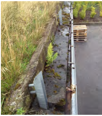
Nedre kant med torvholdestokk.
