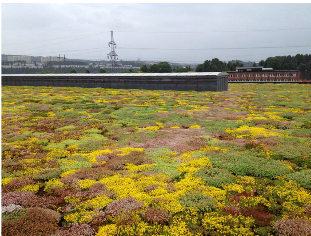
Figur 3.2. Eksempel på ekstensivt tak, sedumtak. Foto: UMB
