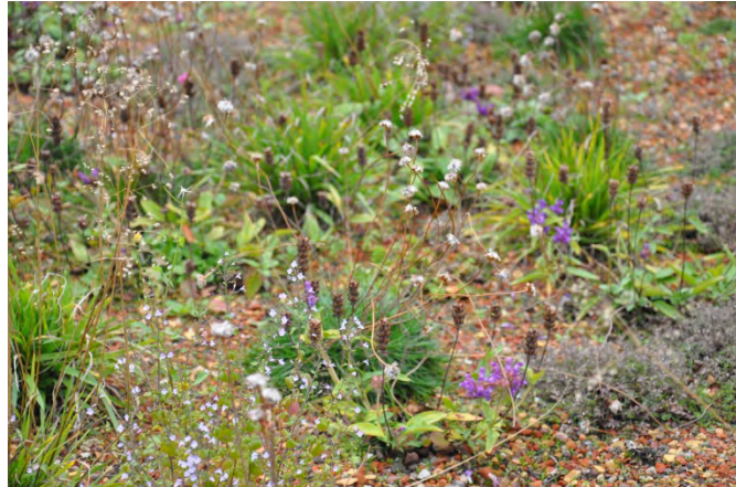
Figur 3.4. Nærbilde av vegetasjonen på et semi-intensivt grønt tak. Foto: UMB/ILP
