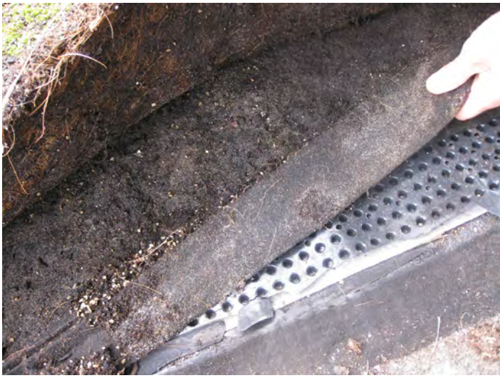
Oppbygningen av sedumtaket. Foto: SINTEF Byggforsk
